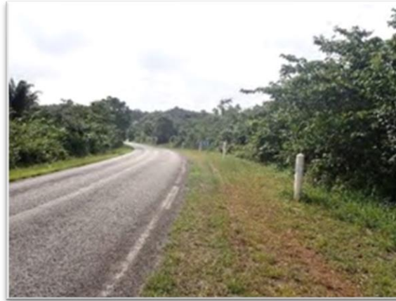
Figure 43 : Bord de la route régulièrement entretenu (Source : Pierre SILLAND et Coralie DALBAN-PILLON).
