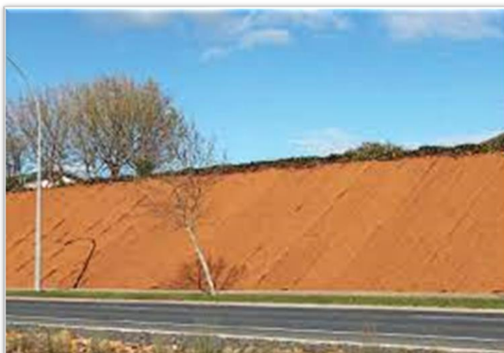
Figure 64 : Exemple d'installation d'un géotextile sur un talus décapé et reprise de talus routier (Source : Guide technique AFB, 2018).
