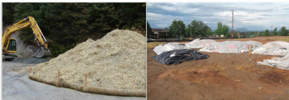
Figure 68 : Protection des dépôts provisoires par mulch à gauche et par géotextile à droite (Source : Guide technique AFB, 2018).
