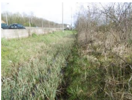
Fossé en bordure de la N12 (au sud)
