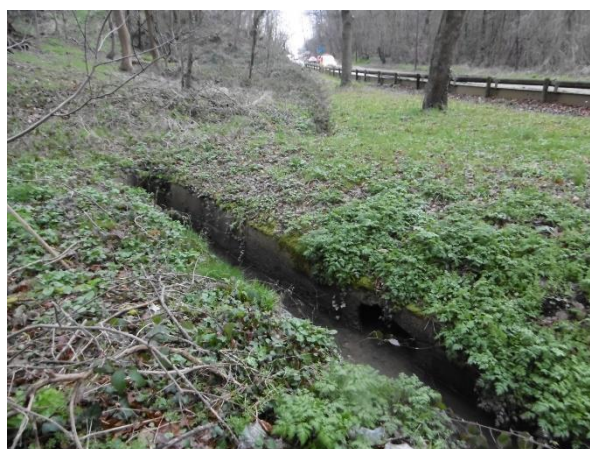
Vue n°2 : Cunette béton aménagée longeant la route D91 Avenue Clément Ader 06/03/20 – SEGEG (ALEZIER S.)
