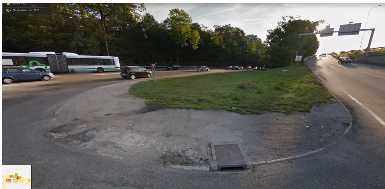
Vue depuis l'intérieur de la bretelle
