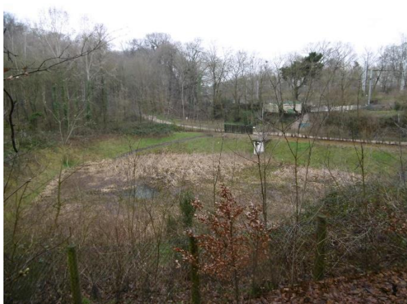
Vue n°1 : Bassin de rétention n°3 N12 06/03/20 – SEGEG (ALEZIER S.)
