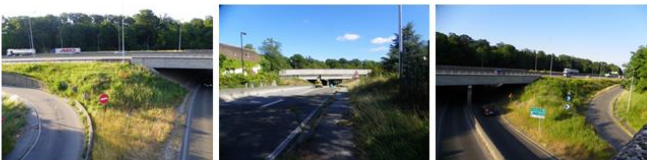
Vues de l'échangeur partie sud
