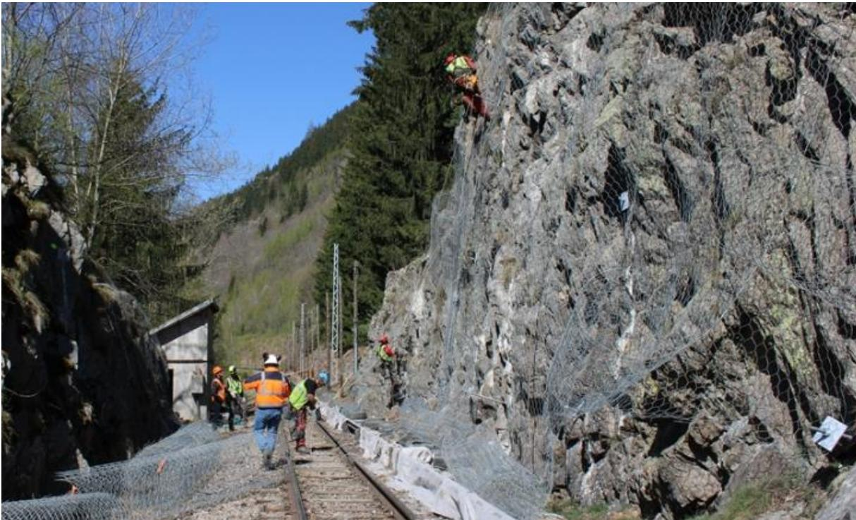
Figure 3: Grillage plaqué ancré (GPA)
