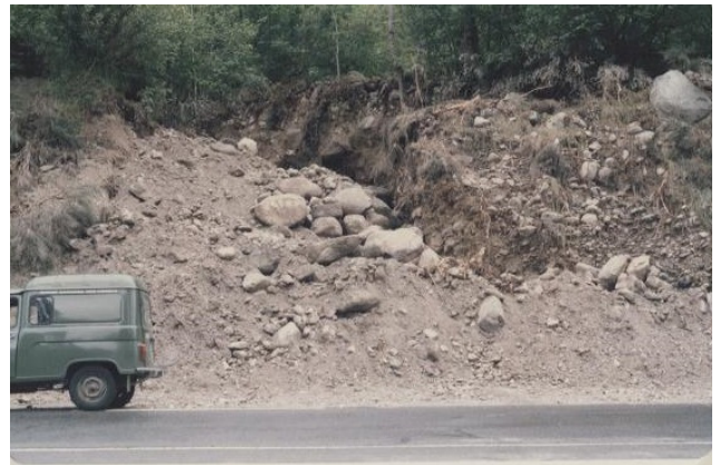
Cône de déjection au niveau de la Rn 20
