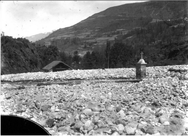
Fontaine ensevelie par les dépôts
