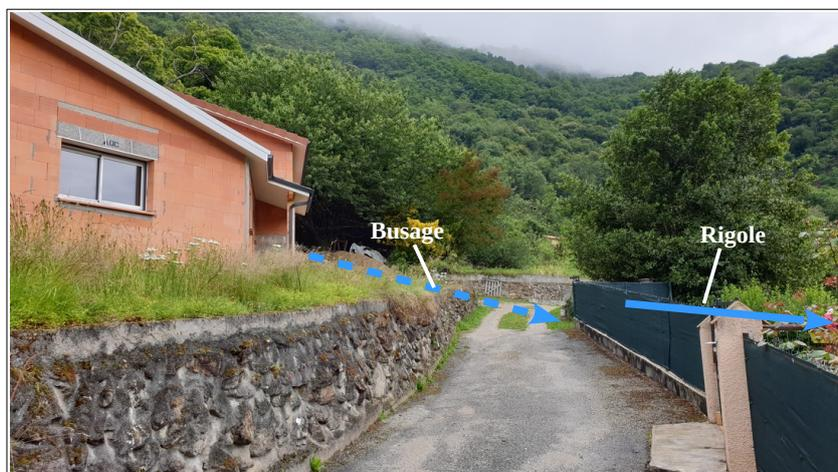
Figure 3.27: zone exposée aux débordements du ruisseau de Fouillerous au niveau du chemin de Camp Grand. Le ruisseau est busé à ce niveau. Il réapparaît temporairement à l'aval du chemin.
