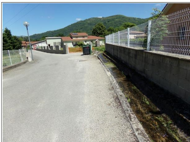
Figure 3.17: vue du chenal du ruisseau parallèle au chemin du Communal (tronçon de section très étroite à ce niveau).
