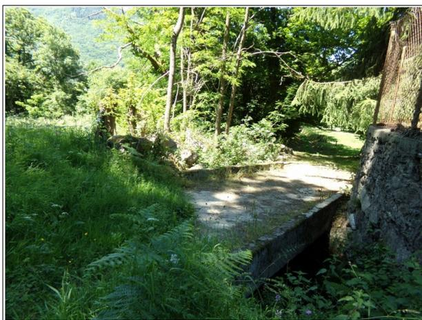
Figure 3.14: franchissement du chemin de la Nougarède par le ruisseau de Rouy (risque de débordement en rive droite).
