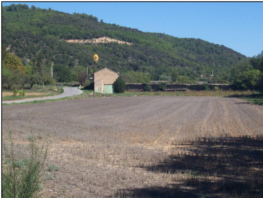
Figure 10: Mur-digue en amont du village, au niveau de la confluence Puimichel / Rancure (à noter que la submersion des terrains visibles sur cette photo conditionne directement la possibilité de divagations torrentielles se propageant vers le village)
