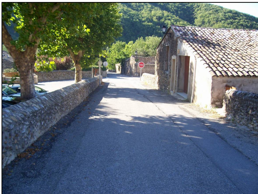
Figure 16: Chenal d'écoulement du ravin de La Fouent dans la traversée du village. Noter l'ouverture coté rive droite, exposée en cas de débit important transitant dans le chenal d'écoulement.
