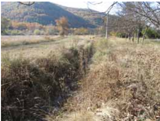
Torrent Puimichel, en aval du pont
