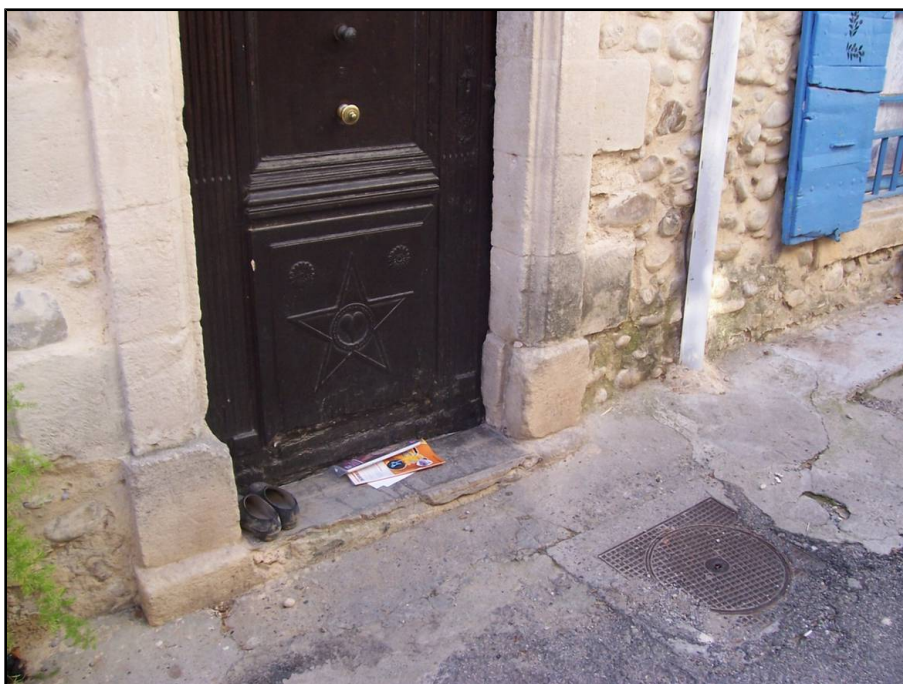
Figure 18: Dispositifs anciens de type batardeau équipant certaines ouvertures dans le vieux-village.
