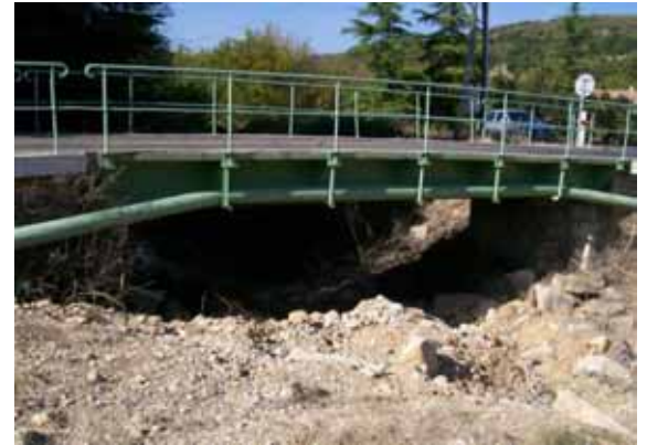
Pont de la RD101
