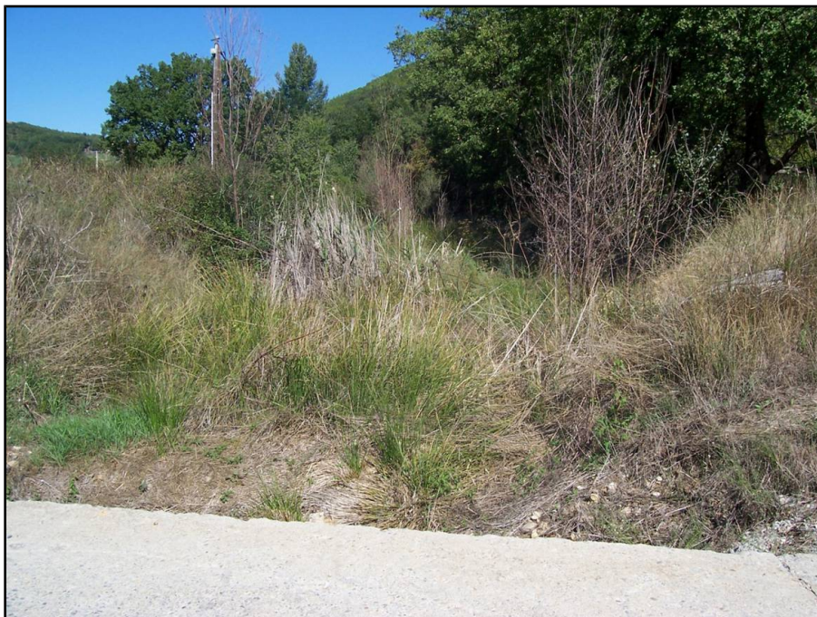
Figure 8: Lit du torrent de Puimichel en amont immédiat du gué de la RD101.
