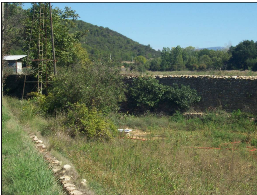
Figure 27: Digue en amont immédiat de la confluence Puimichel / Rancure.
