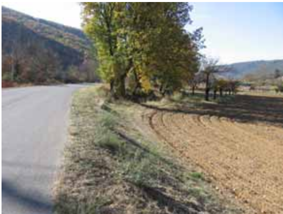
Nouvelle Route Départementale RD12 en remblai
