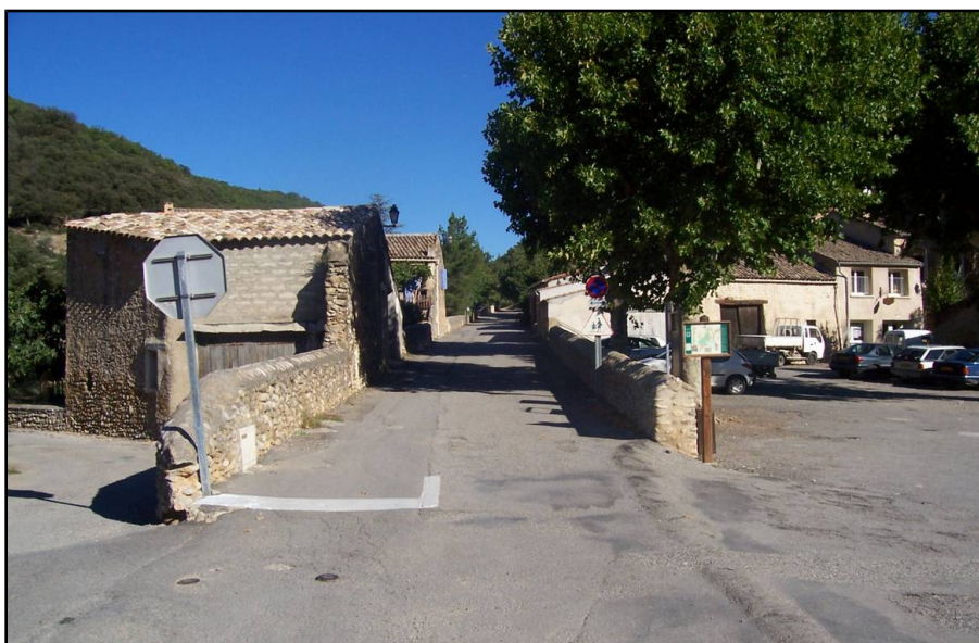
Figure 28: Murs canalisant les eaux du ravin de La Fouent dans la traversée du village.
