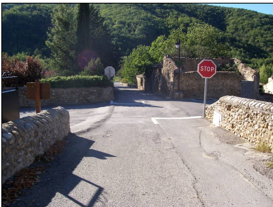
Figure 15: Chenal d'écoulement du ravin de La Fouent dans la traversée du village. Les murs sont interrompus au carrefour avec l'ancienne RD12 mais à l'origine un système de batardeaux était prévu de façon à éviter les divagations latérales.
