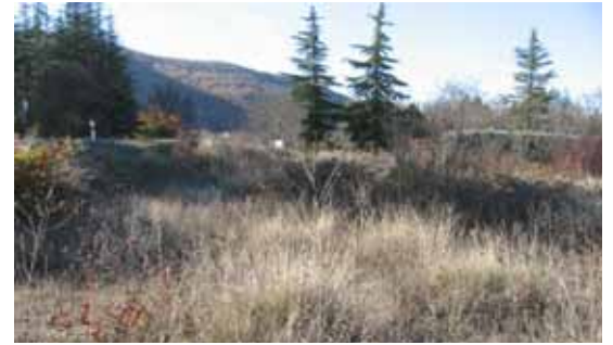
Plaine rive droite en amont du pont Remblai de la route
