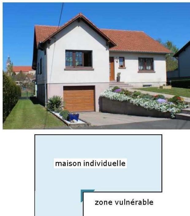
**Figure 2.2.1 : Exemple de bâti de forme en « L »**
