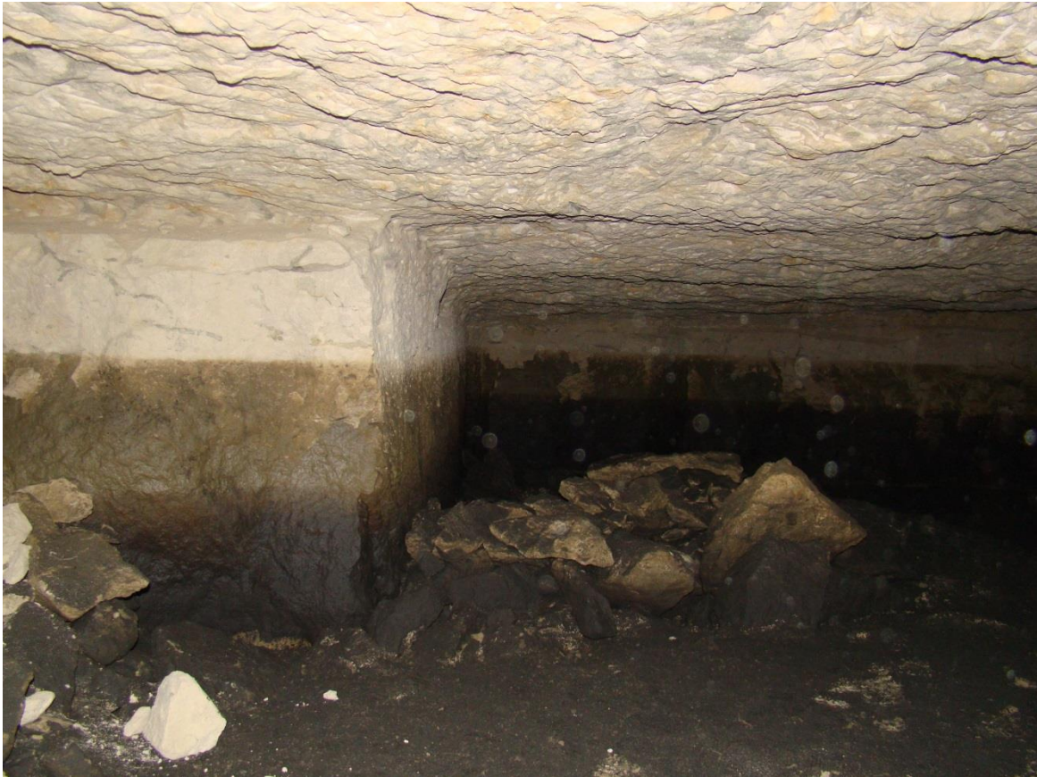
Illustration 9 : Dépôts limoneux liés à d'anciennes inondations à l'extrémité ouest de la carrière
