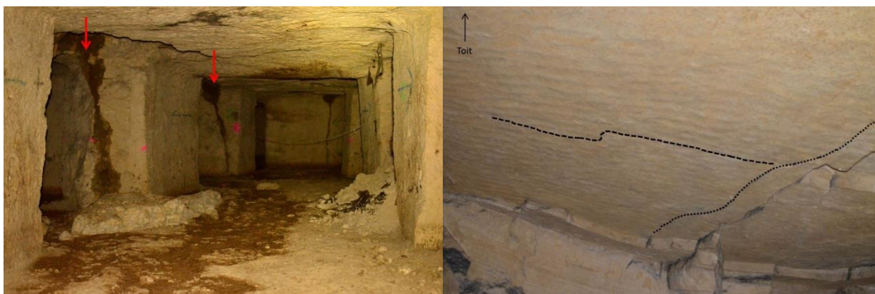
Illustration 18 : Illustration des deux types de fractures cartographiées : à gauche, une fracture naturelle karstifiée qui affecte le toit et les piliers (carrière de Loissail « Le Bas Champaillaume ») et à droite, des fractures mécaniques qui affectent la voûte (carrière de Basly)
