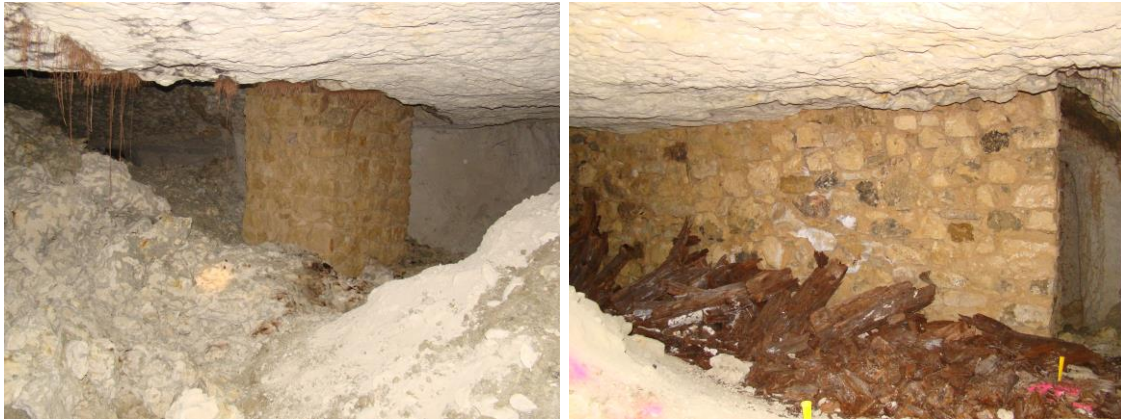
Illustration 11 : Vue sur les piliers maçonnés visibles dans la carrière
