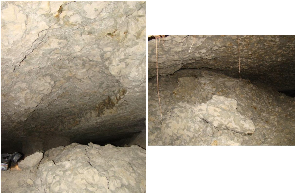
Illustration 14 : Zones de chutes de toit, parfois associées à des amorces de cloches de fontis (à droite)
