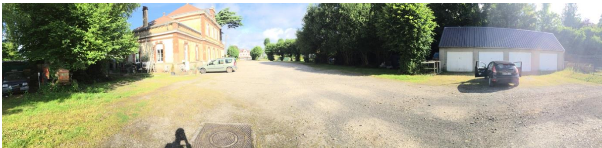
Illustration 6 : Parking de la gare sous-cavée par la carrière de Saint-Langis-lès-Mortagne
