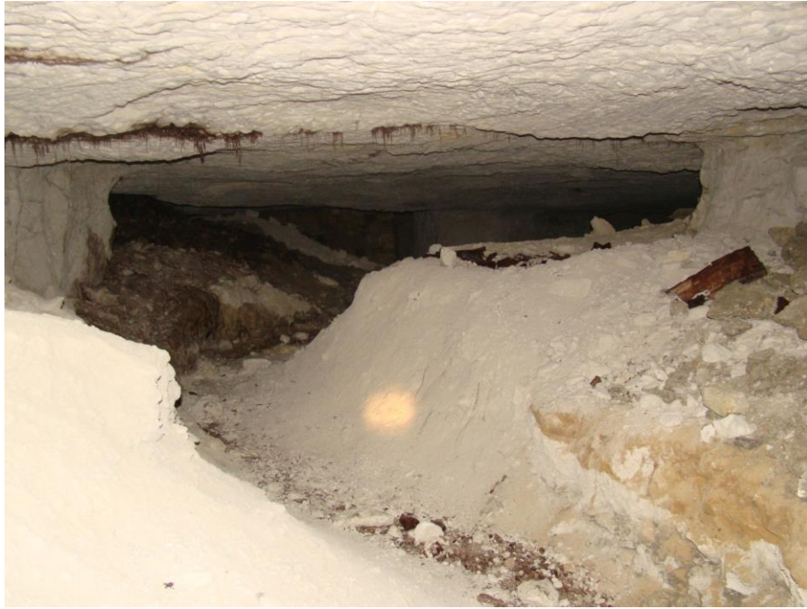
Illustration 12 : Paysage classique de la carrière de Saint-Langis-lès-Mortagne, partiellement remblayée avec présence de radicelles au toit (jusqu'à 80 % et plus dans certains secteurs)
