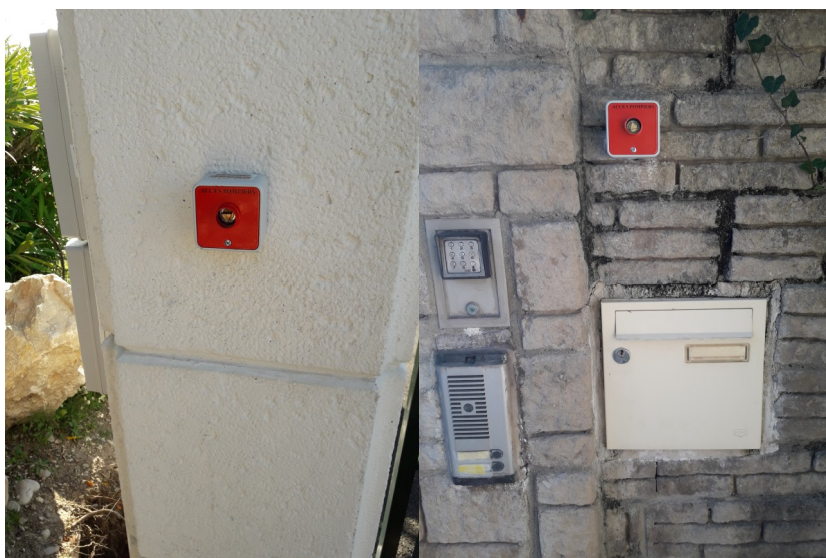
Installation de systèmes de déverrouillage réservés aux pompiers au niveau des deux portails de la liaison © DDTM06
