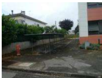
Bâtiment 24 - Abri 2 roues
