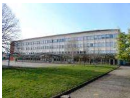
Bâtiment 15 (Locaux collège)
