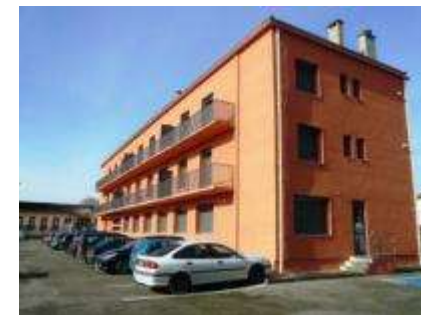
Bâtiment 12 (BTS EFS)
