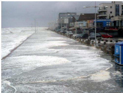
Figure 9 : Franchissement par des vagues du perré de Malo-les-bains (Littoral Dunkerquois-Nord) en décembre 2013.
