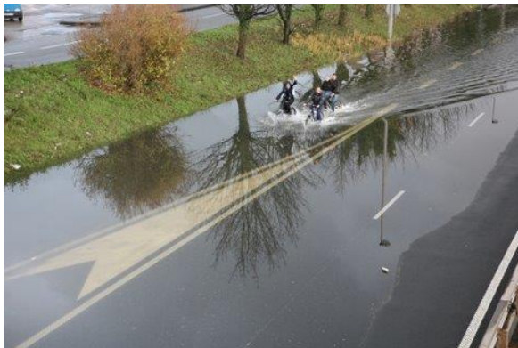
Figure 7 : Inondations de la voie express à Dunkerque (plaine des waterings-Nord) en novembre 2009.
