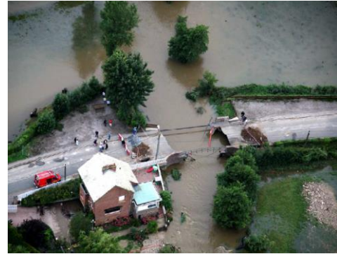
Figure 6 : Rupture du pont de Clerques (vallée de la Hem-Pas de Calais) en août 2006.
