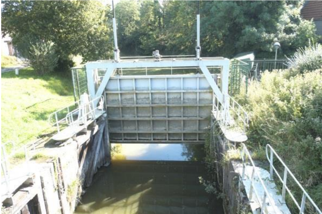
Station de la Basse-Colme : Vanne sur l'ancienne écluse côté aval
