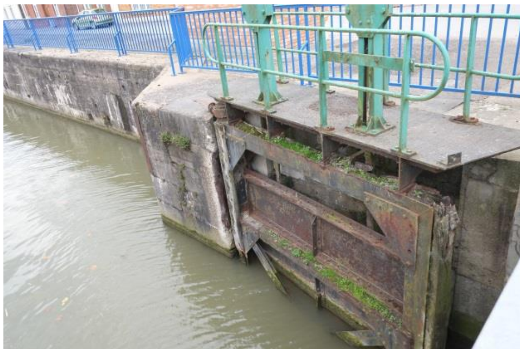
Figure 23 : Porte de l'écluse de Lynck.
