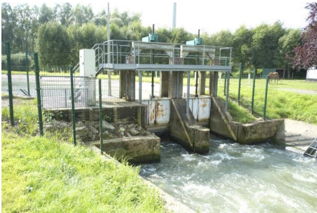
Figure 22 : Vue aval du partiteur de Watten.
