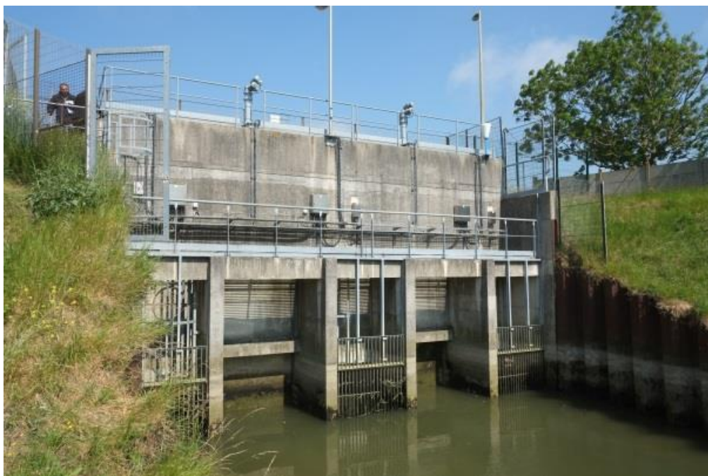
Figure 12 : Station de la rivière d'Oye – Pertuis vannés amont et pertuis de pompage.
