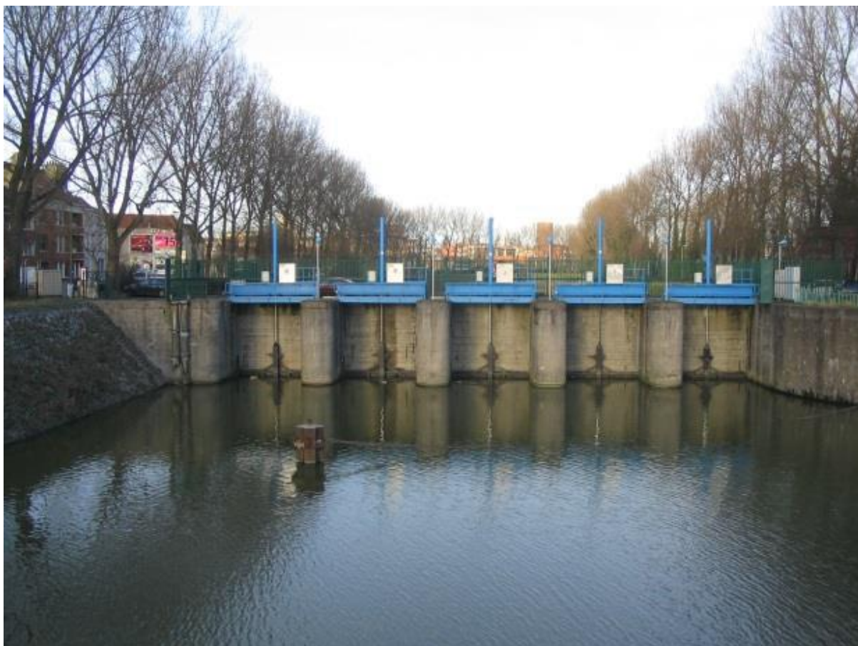
Figure 55 : Amont du barrage vanné de jonction.
