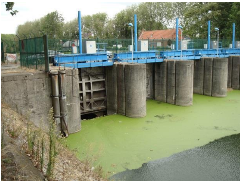
Barrage vanné de jonction : Batardeau déversant sur la vanne n°1, en gestion d'été
