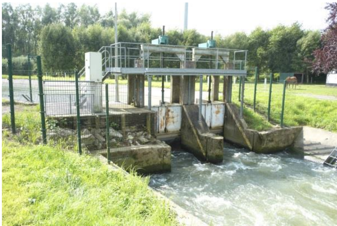
Vue aval du partiteur de Watten
