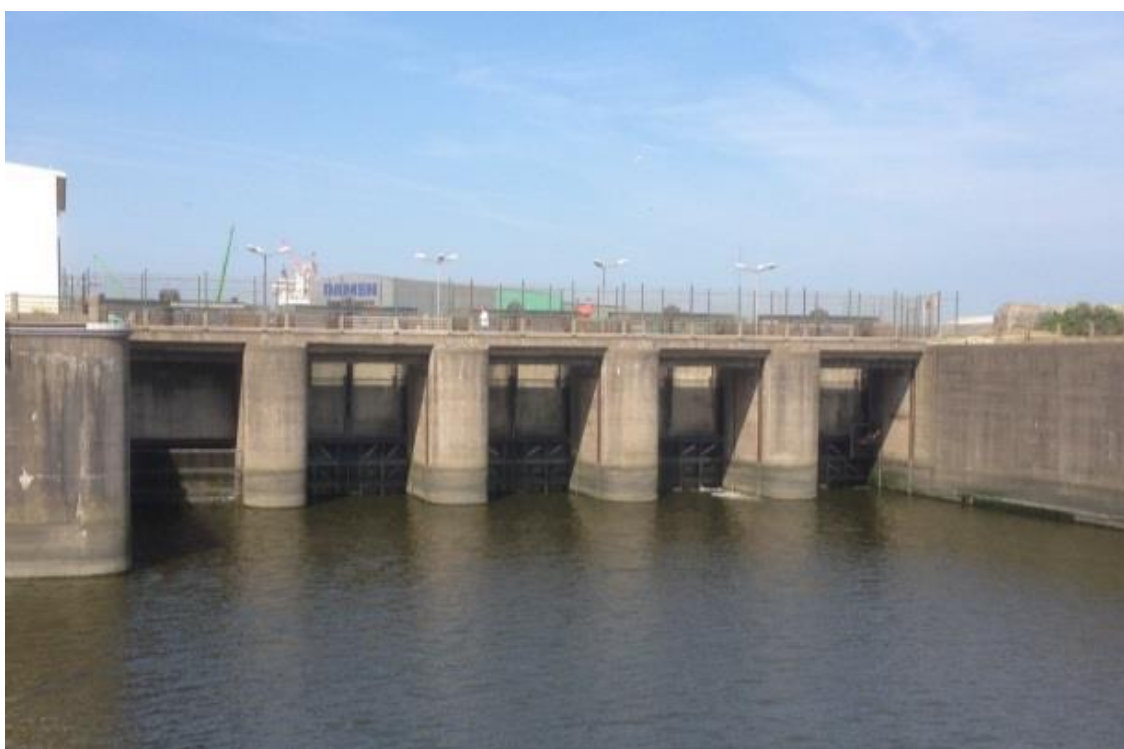
Figure 14 : Station de Tixier – Pertuis vannés côté amont.
