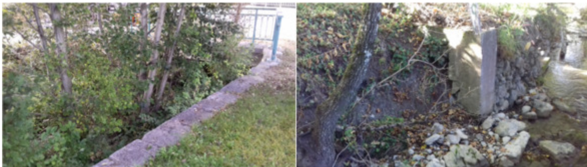
fig. 8 : Cours d'eau envahi par la végétation à l'amont de la Route Napoléon et érosion de berges à l'amont d'une protection en pierre sèches consolidée par un bloc béton.
