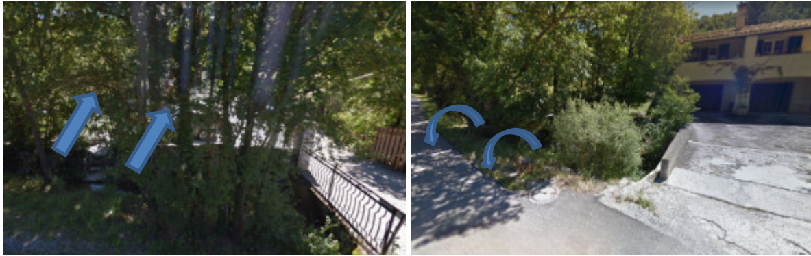
fig. 25 : photos des sections situés à l'amont du pont et du pont 10 (Google Street View)
