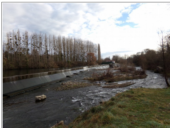
Figure 3.1: L'Ariège au niveau de l'usine électrique des Rives (sud de la commune).
