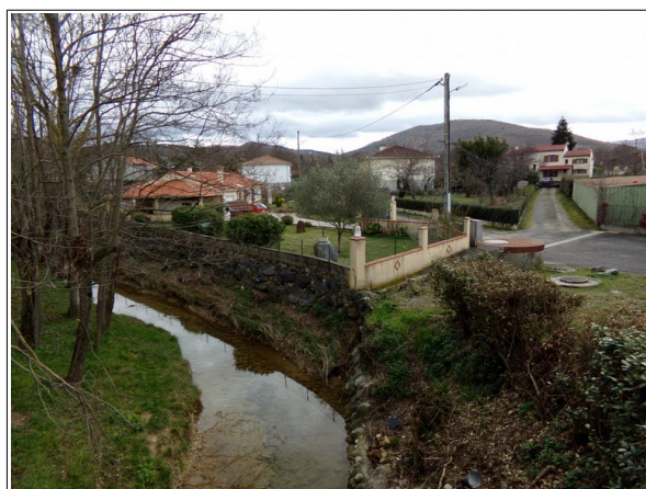
Figure 3.31: quartier de l'impasse du 8 mai 1945 inondable à l'amont de la RD 624.
