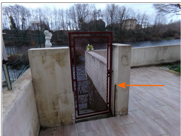
Figure 3.8: au 35, rue du Barry-d'en-Bas, l'Ariège a atteint en décembre 2019 quasiment le niveau du rail pour batardeau fixé sur le pilier.
