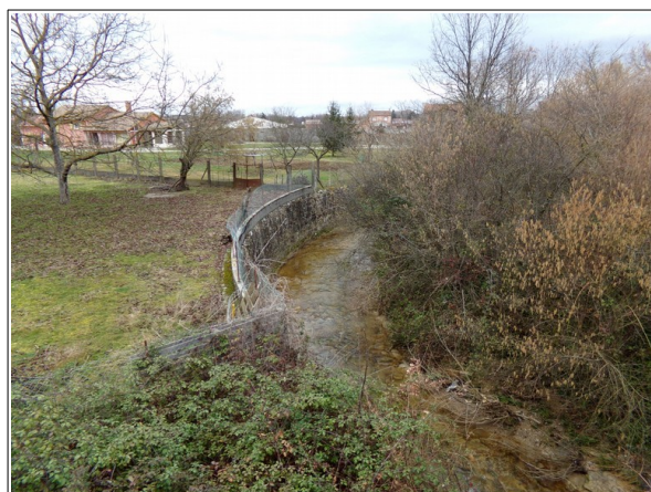
Figure 3.25: ruisseau de Dalou à l'aval de la voie ferrée et berge bétonnée (rive gauche).
