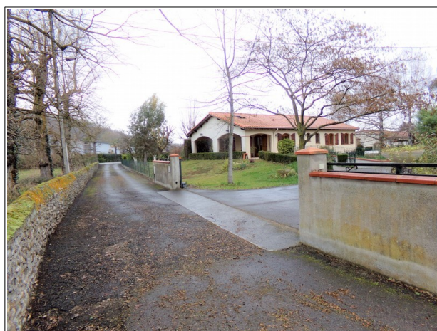
Figure 3.33: quartier sud-ouest d'Armaut inondable par le ruisseau de Loubencat. La maison visible sur la photo a déjà été encerclée par une lame d'eau d'une vingtaine de centimètres.
