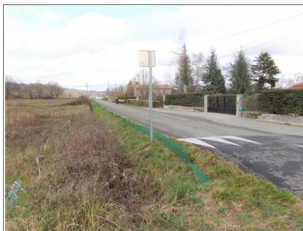
Figure 3.35: ruisseau du Fourtic à l'aval du croisement avec la rue des Sapins. Une surverse sur le chemin de Lesquet est possible (chemin visible sur la photo).
