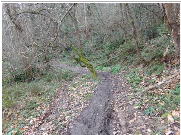
Figure 3.54: zone de déformations de terrain par fluage au niveau du sentier de Fourtic.
