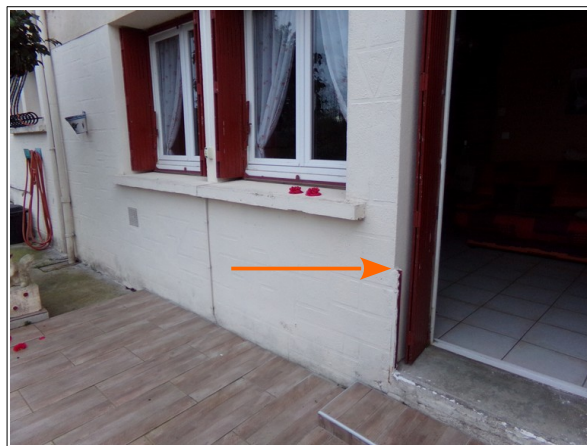
Figure 3.7: maison du 35, rue du Barry-d'en-Bas, la crue de décembre 2019 a atteint le niveau du rail pour batardeau (maison inondée par plusieurs décimètres d'eau).
