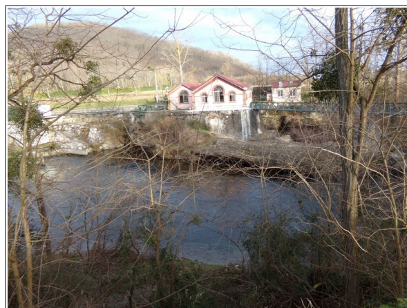
Figure 3.2: bâtiment inondable de l'usine électrique des Rives.
