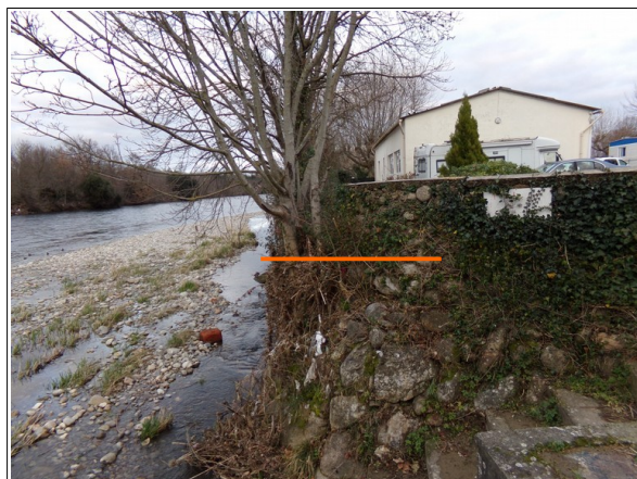
Figure 3.10: Ancien camping de Varilhes et laisse de crue à la base de la murette ceinturant l'espace remblayé (herbes accrochées).
