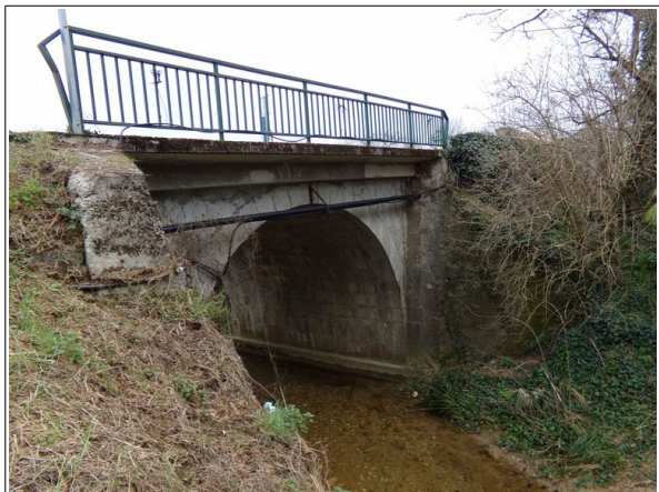
Figure 3.23: pont de la RD 13 dans le quartier d'Armaut.
