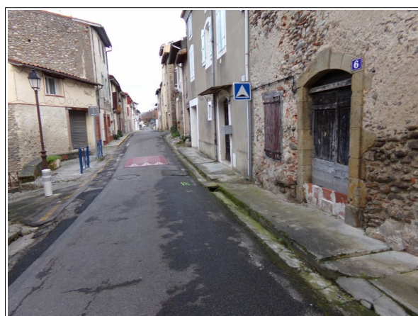
Figure 3.6: Vue générale de la rue du Barry-d'en-Bas et du bâti presque totalement inondable.
