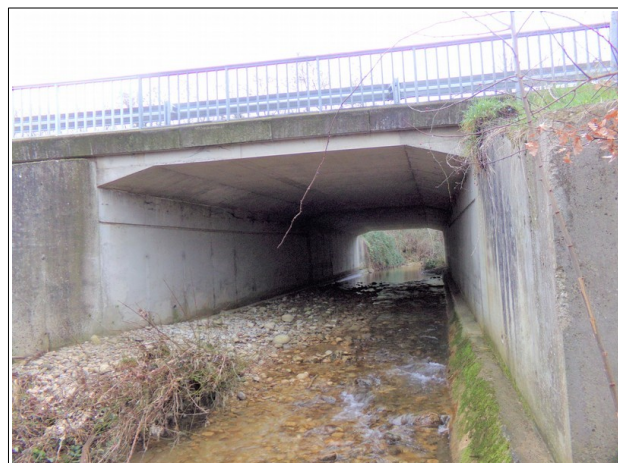
Figure 3.19: pont de la N 20 vu depuis l'aval.
