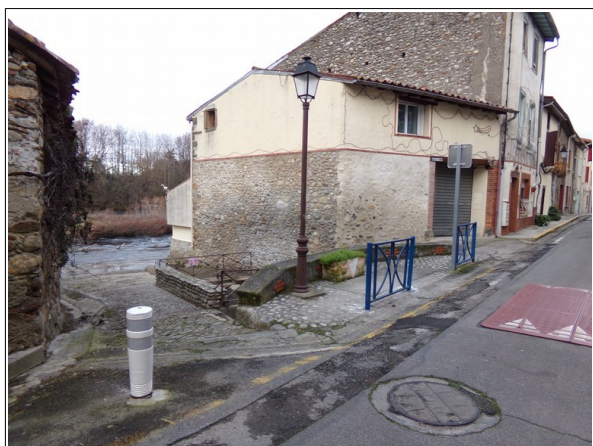
Figure 3.5: quartier du Barry-d'en-Bas inondable. le poteau sur lequel était peintes des laisses de crue se situait à l'emplacement du réverbère.
