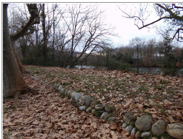
Figure 3.12: petit endiguement au droit de l'ancien camping, au niveau du stade de Varilhes.
