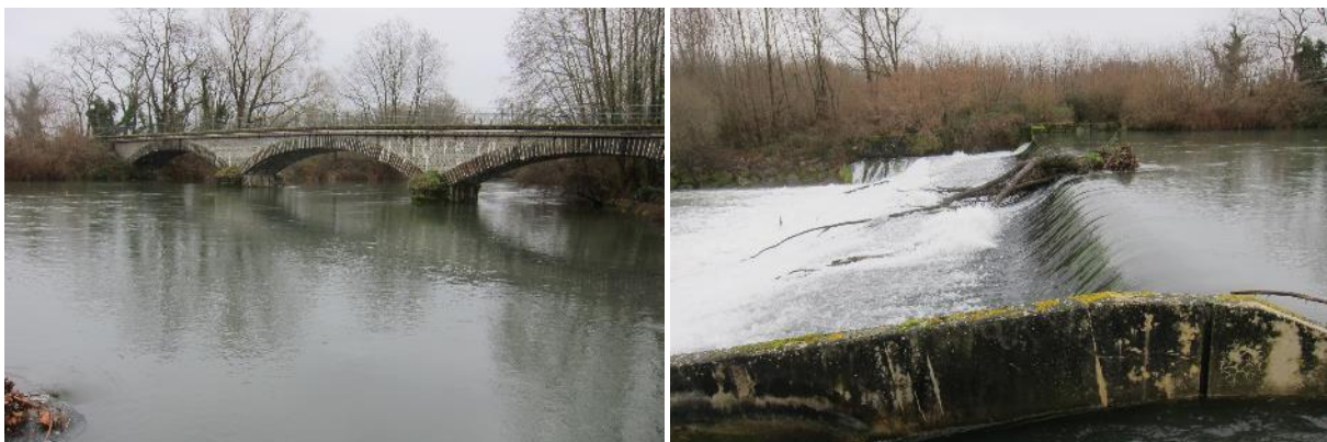
Figure 24. Photographies du pont de Sarniguet et du seuil de Sarniguet
