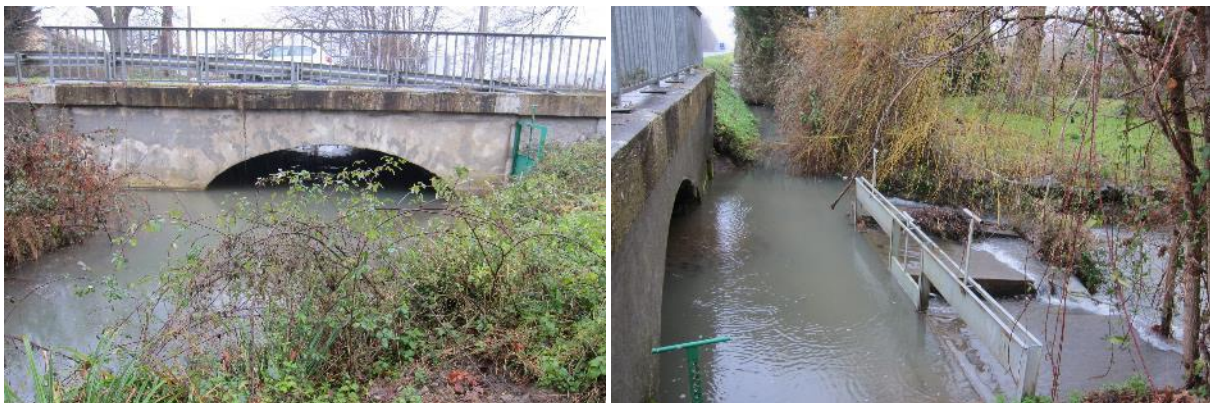
Figure 26. Franchissement de l'Aule sous la RN21 et vannage en aval du pont
