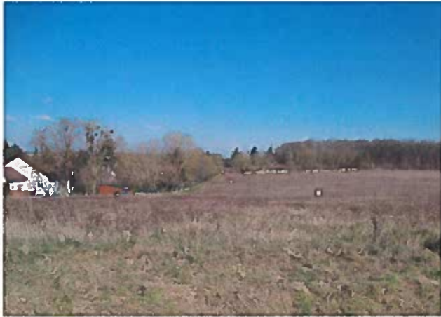
Carrière de la Tour Girard : cheminées d'aération en surface (des cheminées se situent à quelques mètres des habitations)
