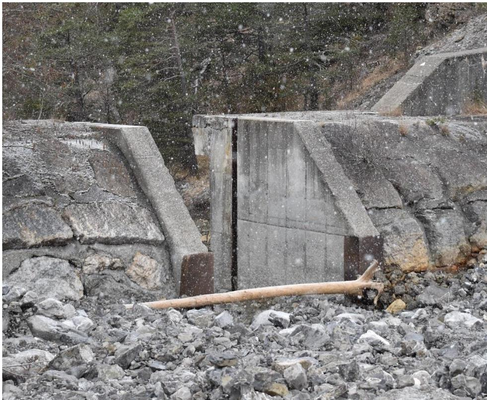
Figure 8 : Glissière verticale sur l'ouvrage de fermeture de la plage de dépôt (Amétén, fév. 2020)
