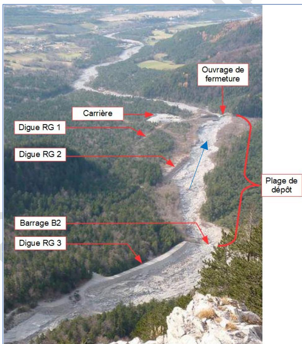
Figure 55 : Vue d'ensemble de la plage de dépôt
