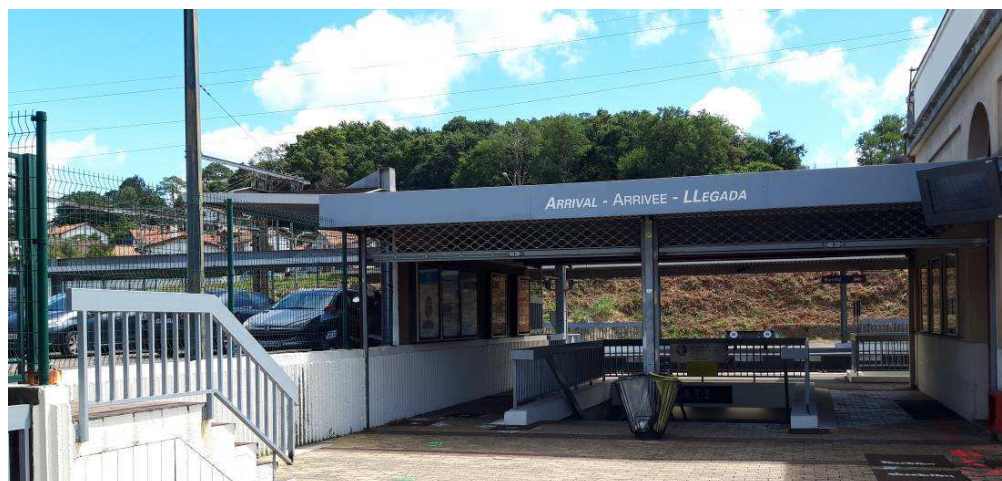
Souterrain de traversée des voies ferrées (5)
