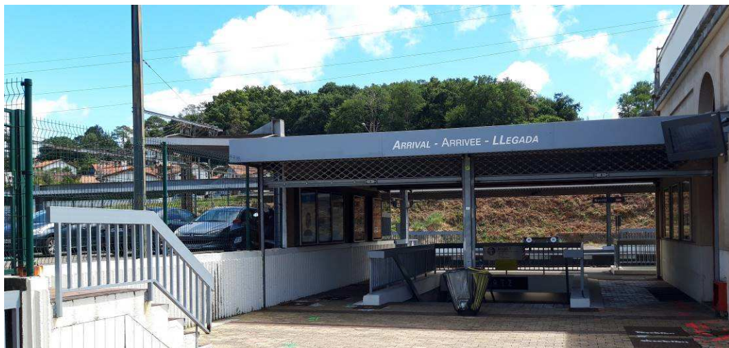
Souterrain de traversée des voies ferrées (5)
