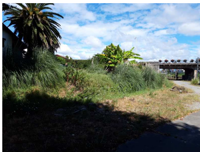
Talus colonisé par des espèces exotiques envahissantes
