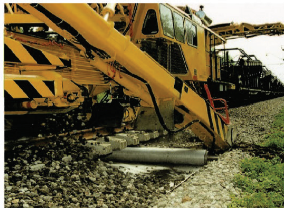
Exemple de mise en œuvre d'un système anti-végétatif sous ballast
