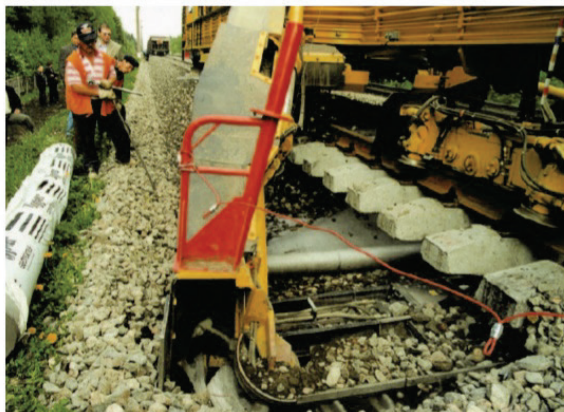
Exemple de mise en œuvre d'un système anti-végétatif sous ballast
