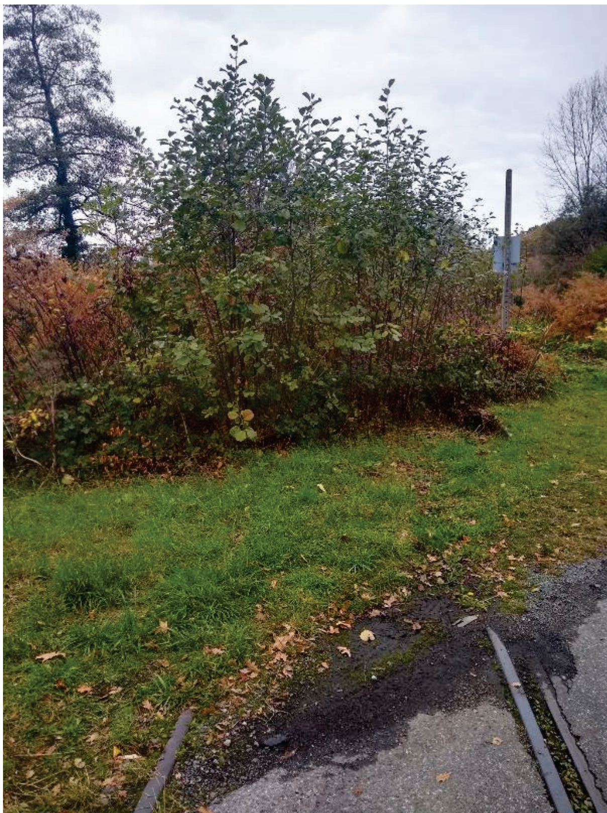
Figure 15. Photographie de la voie prise au niveau de la commune de Pouzac
