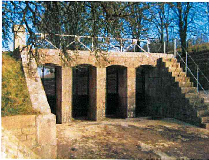
Evacuateur de crues à vannes actuel
