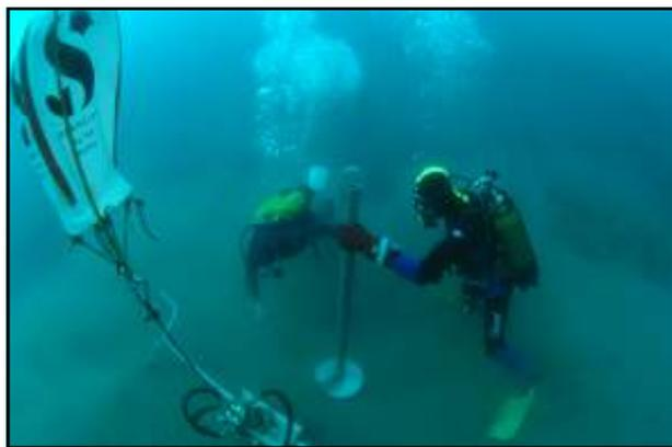
Mise en position d'une ancre à 1 étage de spire
