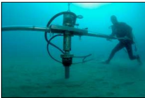
Vissage direct par clé hydraulique
