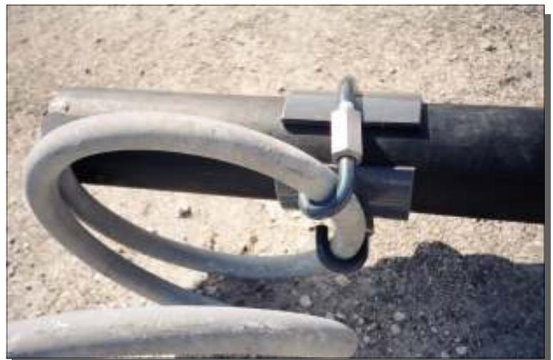
L'amarrage de la conduite (exemple d'un faible diamètre) est réalisé sans aucune pièce saillante; aucun risque d'accrochage d'engins de pêche
