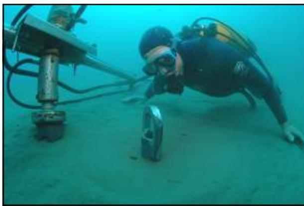
Vissage de l'ancre jusqu'à affleurement du sol.
