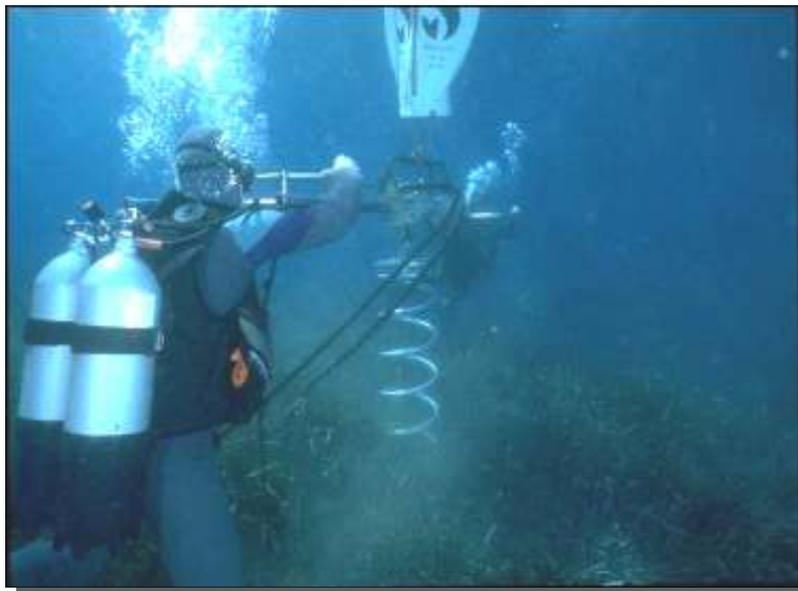
Vissage d'un enroulement hélicoïdal d'acier spécial *HARMONY* Type P
