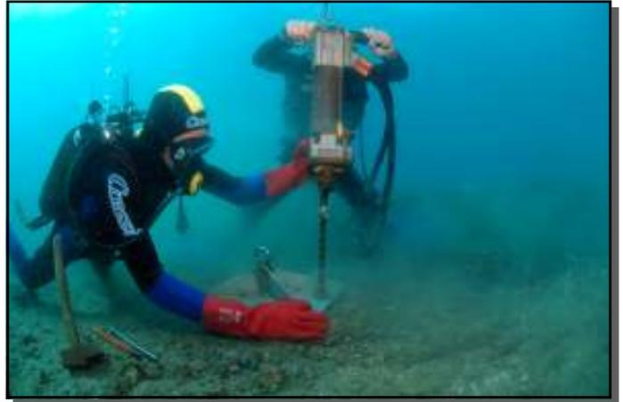
Perçage de la roche avec perforateur hydraulique pour scellement des tirants.
