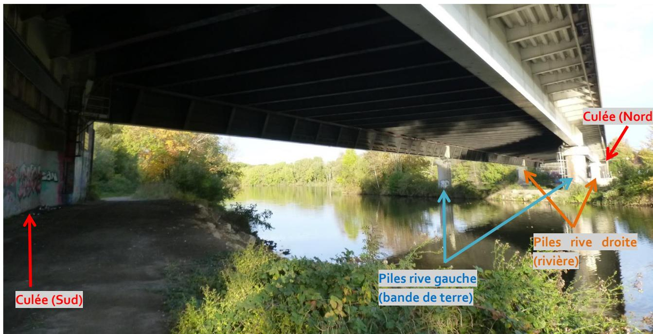
Figure 4 : Localisation des différents appuis du viaduc (vue du dessus)
