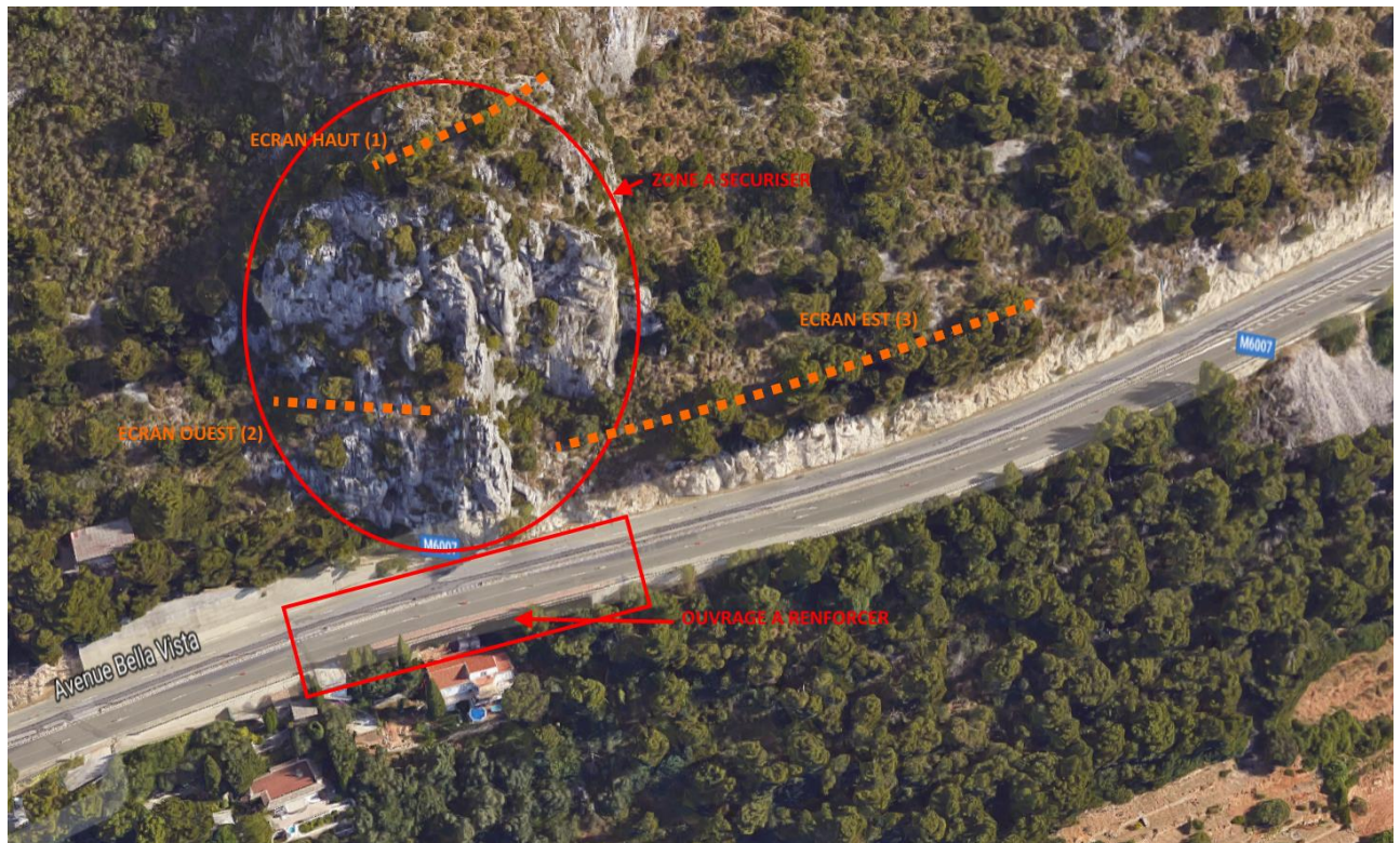
Zoom sur les différentes zones de travaux
