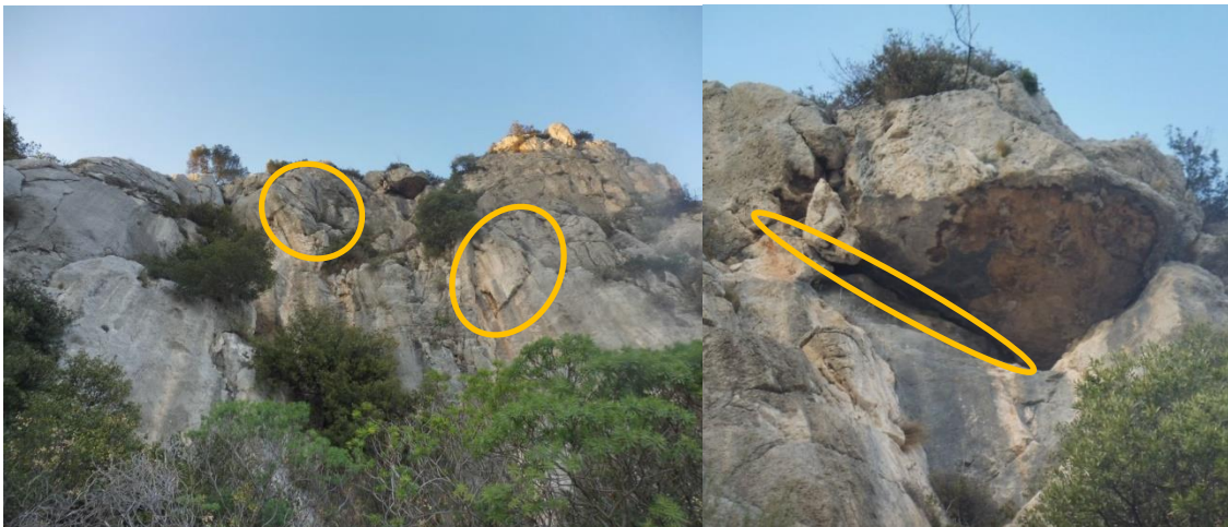
Figure 14 : Secteurs et fissures favorables aux chiroptères
