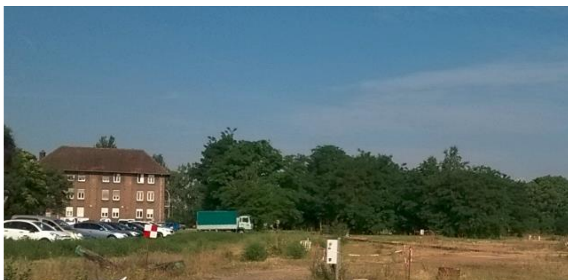
Photographie n°3 : Vue du site SNCF comprenant différents bâtiments (services, postes techniques, foyers)
