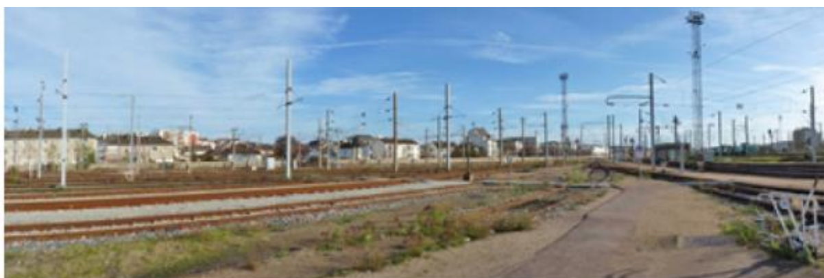
Photographie n°1 : Vue du faisceau de voies ferrées reliant Paris-Saint-Lazare à Caen-Le Havre
