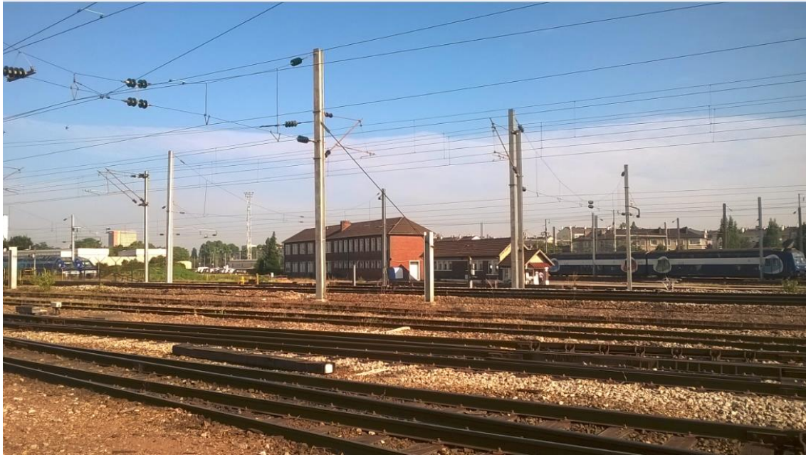
Photographie n°6 : Vue sur les installations de garage du site de Mantes
