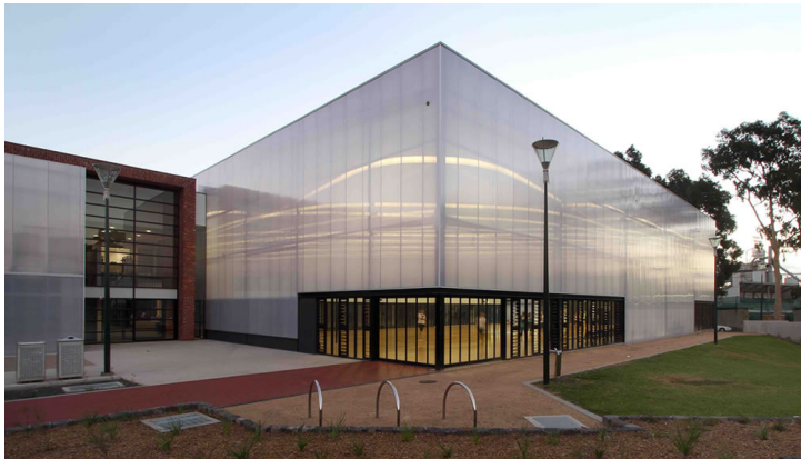
Façade extérieure en Dampalon Matériau translucide (D R)
