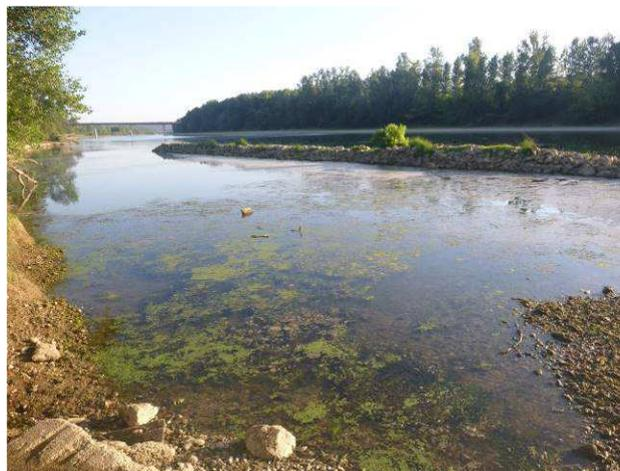
Rive gauche – Merlon en enrochement et annexe hydraulique
