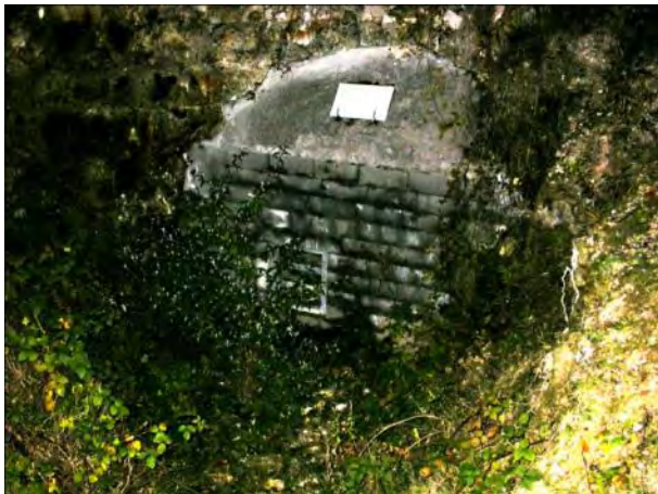
Entrée aménagée par le CENP de la cavité du Bois de Milly-Fief Photo : Ecothème
