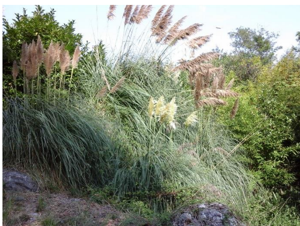
Non débroussaillage avant l'hiver de la végétation invasive qui surplombe l'exutoire de l'ancien moulin
