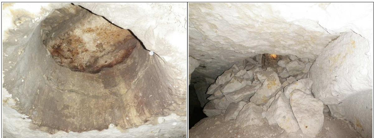
Figure 9 : Anciens puits d'accès fermé ou remblayé depuis la surface.
