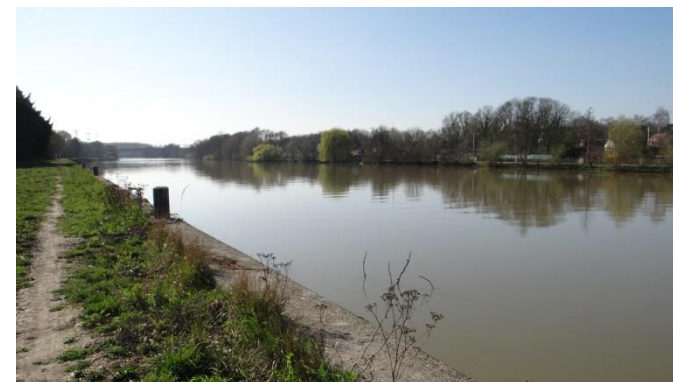
Berges cimentées au droit de la zone d'étude et zone de quai de la plateforme (Egis, 2017)
