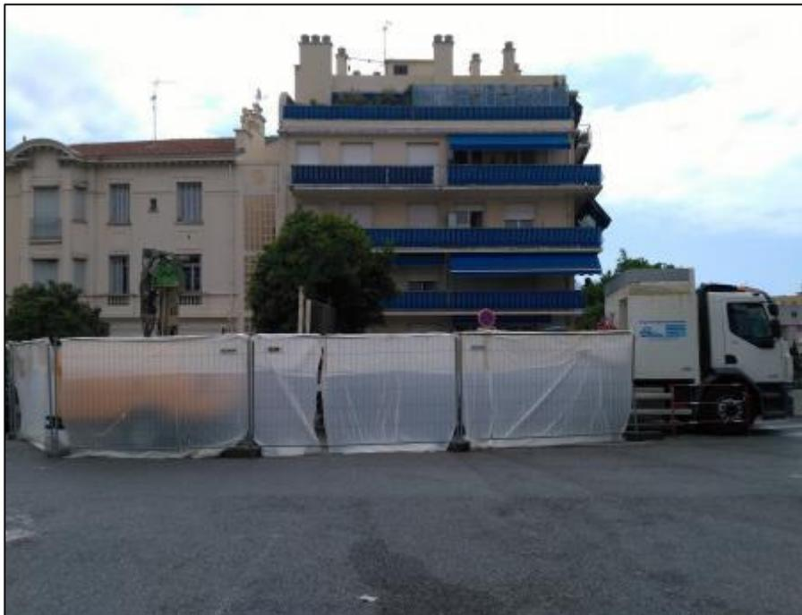
Photo 11 : Sécurisation de la zone autour du point de sondage S2E-PZ1 en partie sud-ouest du site – Mise en place de clôture mobile de chantier et de polyane
