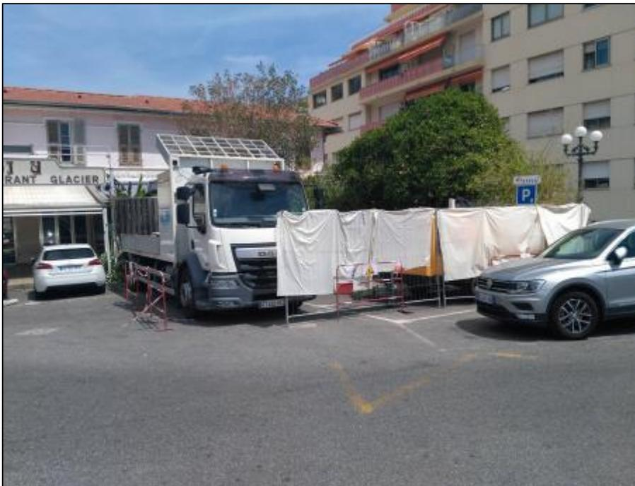
Photo 16 : Sécurisation de la zone autour du point de sondage S2E-PZ2 en partie sud-est du site – Mise en place de clôture mobile de chantier et de polyane
