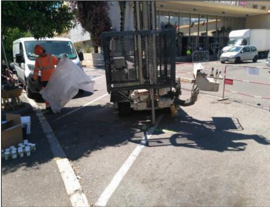
Photo 13 : Localisation du sondage S2E-PZ1 équipé en piézomètre jusqu'à 18 m de profondeur en partie sud-ouest du site
