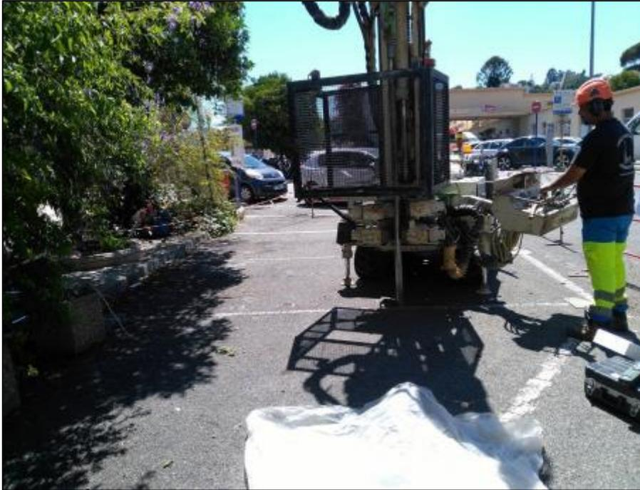
Photo 15 : Localisation du sondage S2E-PZ2 équipé en piézomètre jusqu'à 18 m de profondeur en partie sud-est du site
