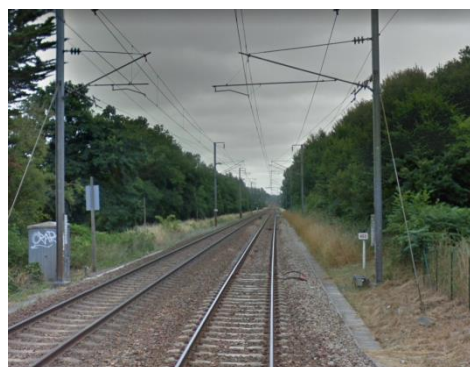
Abords végétalisés, à proximité de Lamballe.
