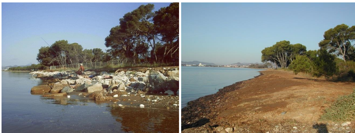
Fig. 125. Photos avant et après travaux de désenrochement (2011)
