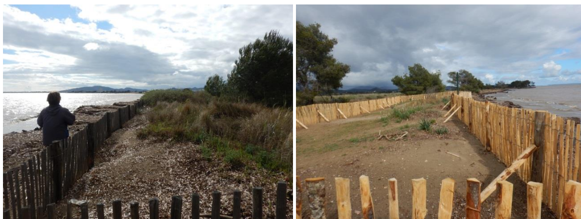
Fig. 124. Photos de la dune avec ganivelle actuellement en place
