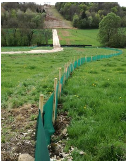
Fig. 122. Exemple de mise en place de grillage lors du chantier GRTgaz Val-de-Saône (Artelia – 2017)
