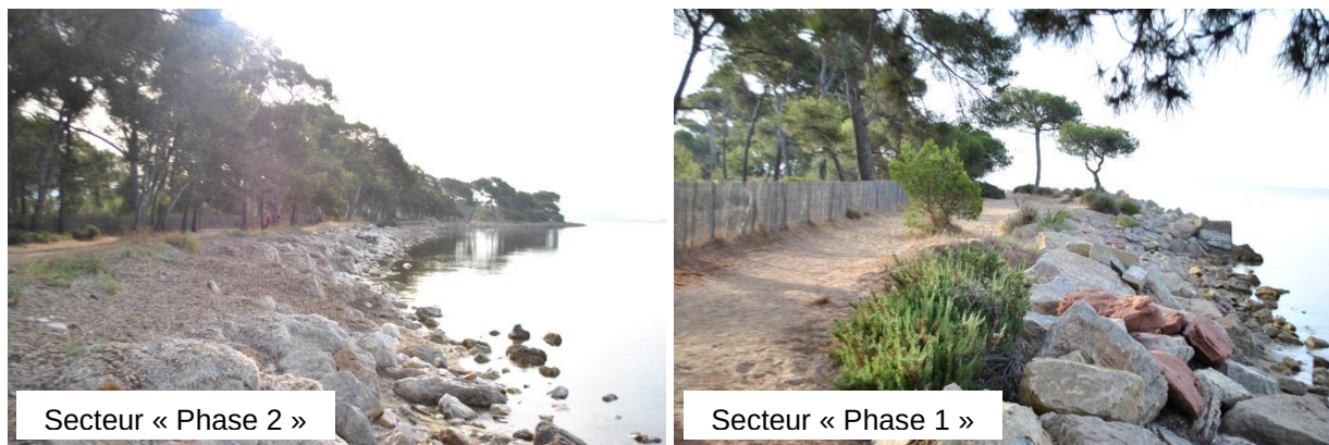
Fig. 8. Photographies des enrochements actuels
