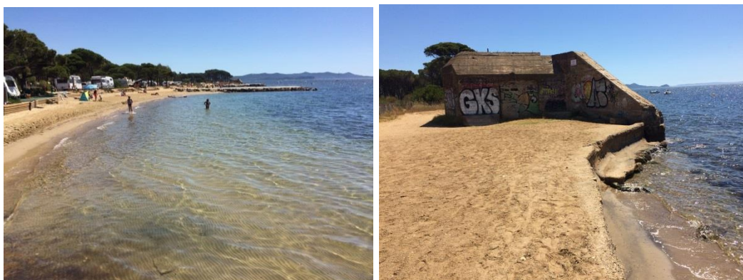
Fig. 52. Plages & épis (à gauche), mur et blockhaus (à droite)
