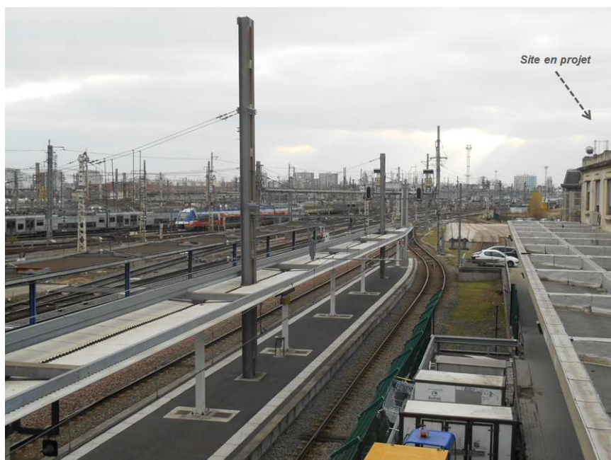
Photographie 21 : Vue des voies SNCF prise depuis le pont du Guit
