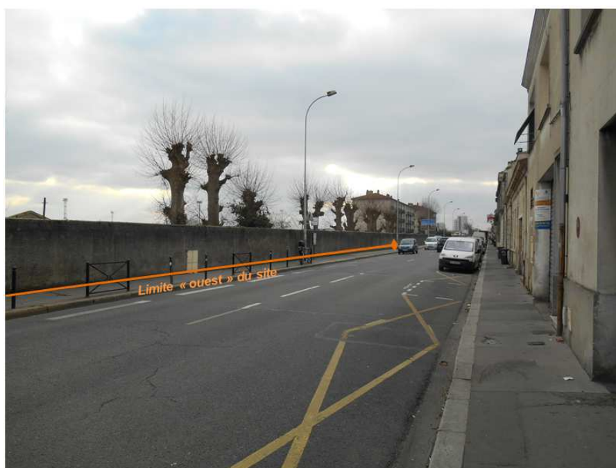
Photographie 6 : Rue Amédée St Germain prise à hauteur du site (Vue en direction du Sud)
