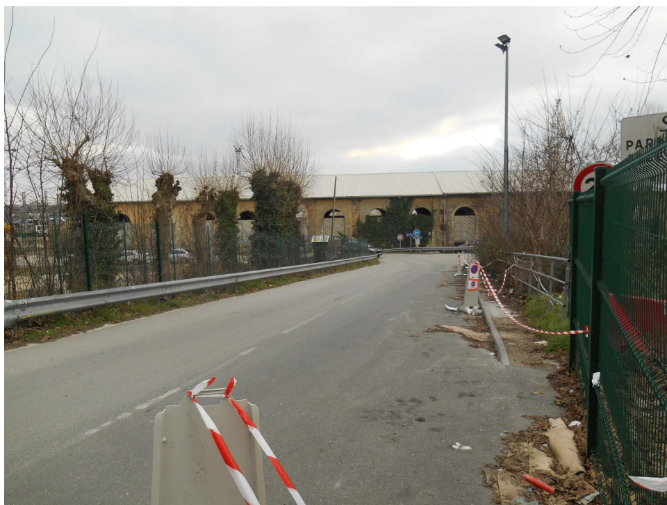
Photographie 7 : Rampe d'accès au site depuis le n°82 rue Amédée St Germain (Vue en direction du sud-est)
