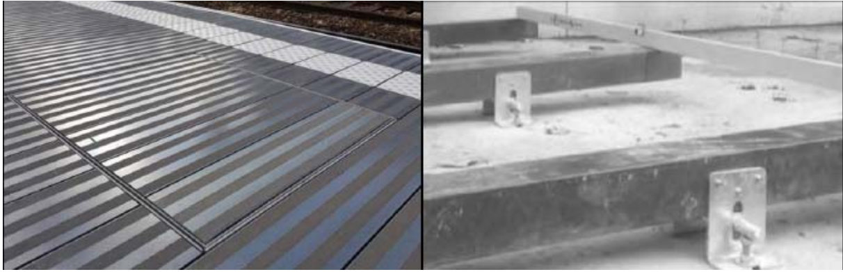
Exemple de platelage composite et structure porteuse.
