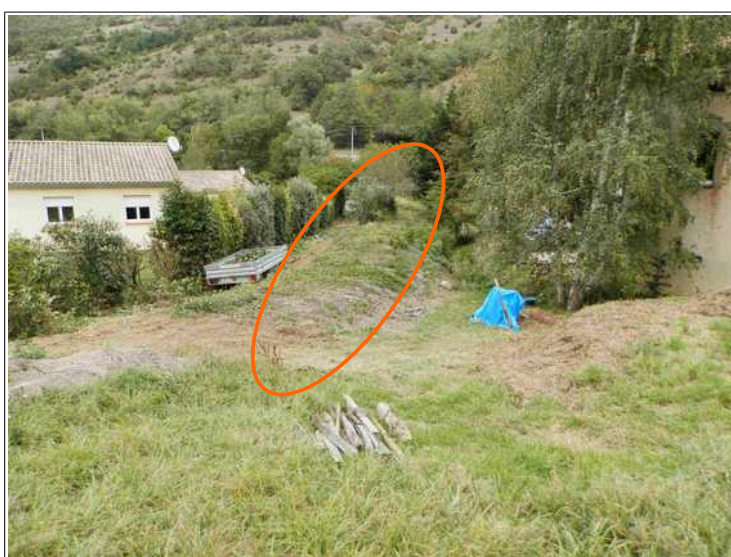
Figure III.11: digue en rive gauche du ruisseau édifée pour la construction de trois pavillons.
