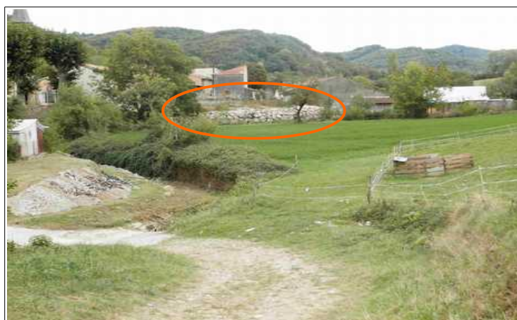
Figure III.3: le Méridic dans la traversée du village de Gudas. On notera en arrière plan les berges enrochées.
