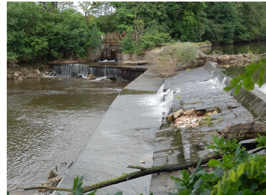
Vue 4 : déversoir (juin 2016)
