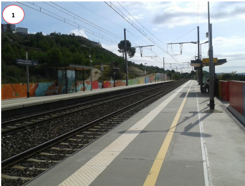
Vue générale sur la halte de VAMP depuis le quai ouest
