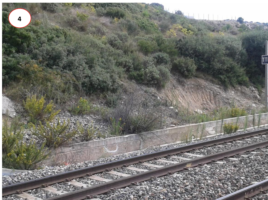
Zone de prolongement du quai est, vue prise depuis le quai ouest
