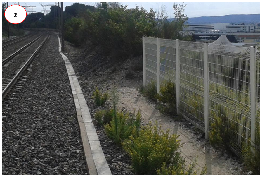
Zone de prolongement du quai ouest, vue prise depuis l'extrémité sud du quai existant
