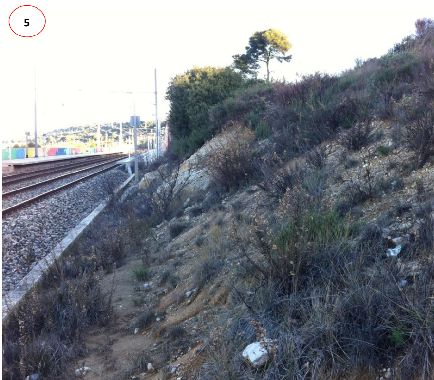
Zone de prolongement du quai est, vue prise depuis le sud-est de la halte
