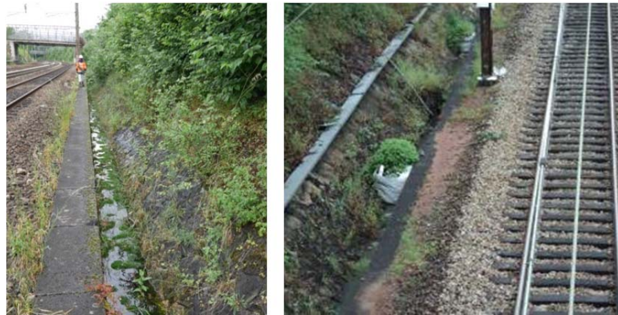
Figure 14 : Fossés béton situés en bordure de la plate-forme ferroviaire (Source : Setec)
