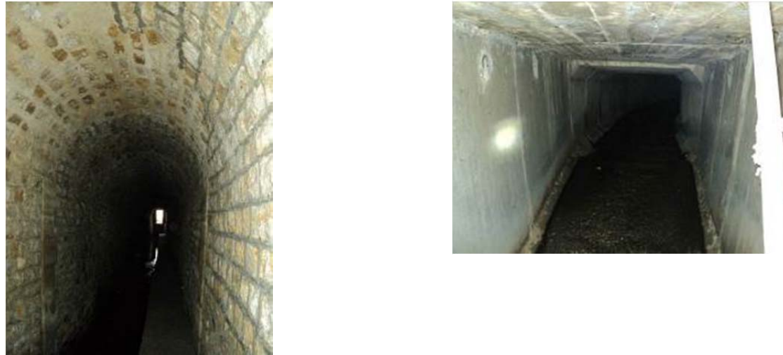
Figure 12 : Aqueduc du Blutin (Source : Setec)
