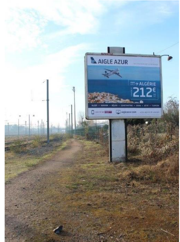
Prise de vue de la zone d'implantation projetée pour le poste d'aiguillage informatisé
