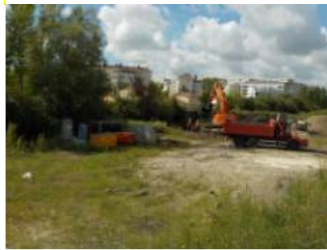
Vue sur la partie sud-est du site
