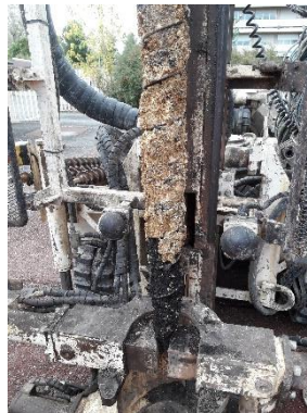
Remblais sablo-argilo-graveleux beiges/ocre
