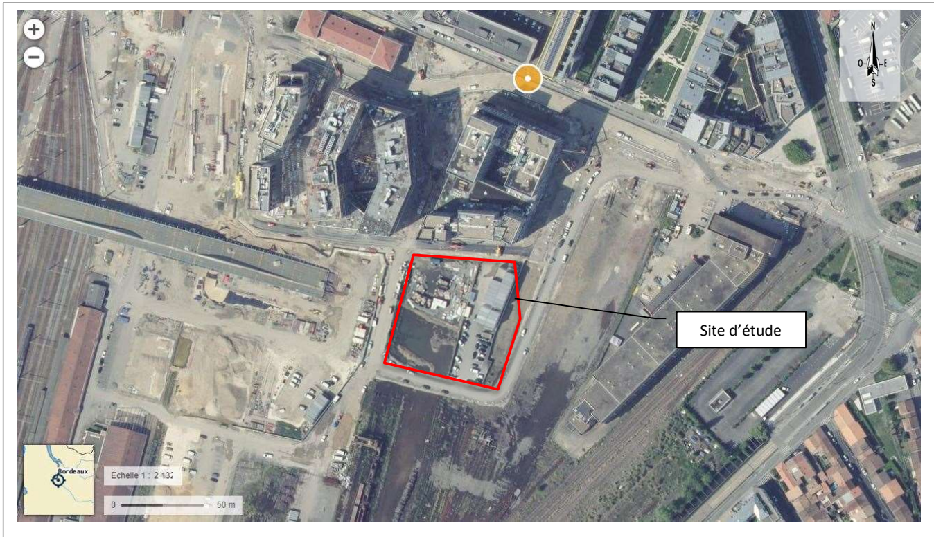
Figure 3 : Vue aérienne de l'opération projetée HEKA – ILOT 8.7 - Source : cliché mai 2018 IGN
