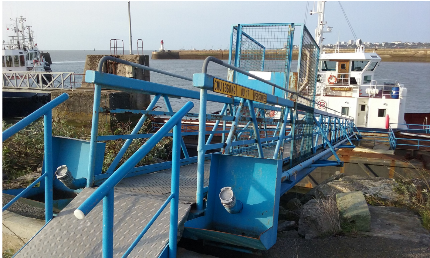
PASSERELLE D'ACCES AUX PONTONS
