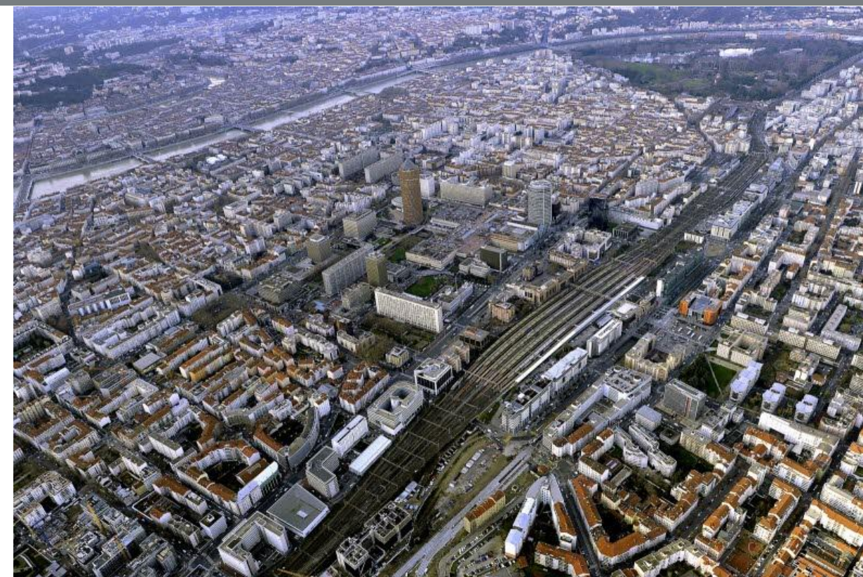
Figure 58 : Vue aérienne sur le site depuis le Sud-Est (Crédit : S. Guiochon pour le Progrès, août 2014)
