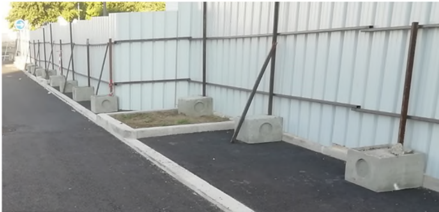
Exemples de clôtures de chantier et de leur mode de fixation
