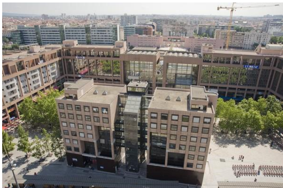
Figure 60 : Vue aérienne de la place Béraudier avant démolition du B10 (crédit : D. Nicole – Bibliothèque Municipale de Lyon, 2010)
