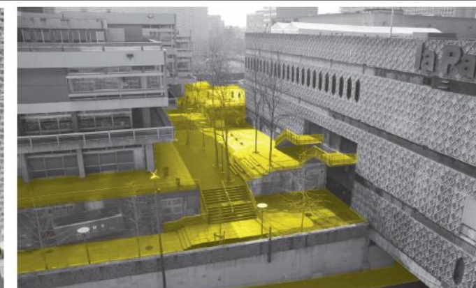
Arrière de la Bibliothèque municipale
