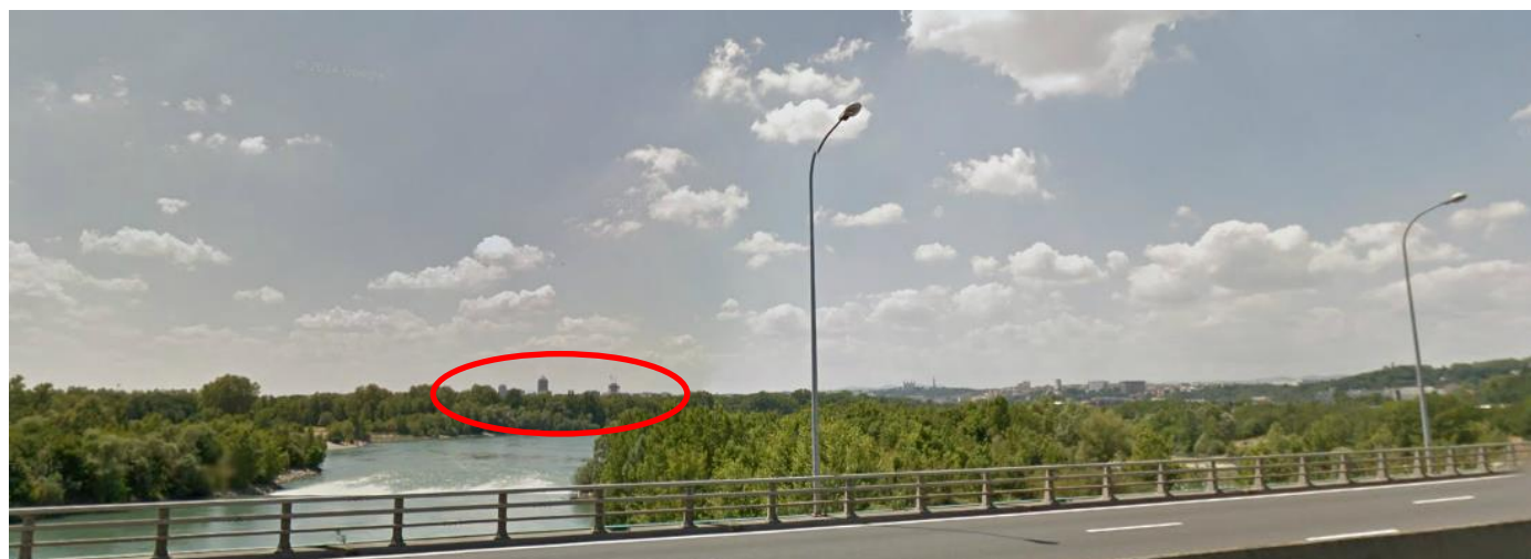
Figure 68 : Vue sur le site depuis le boulevard périphérique Nord (source : Googlemaps, juin 2014)
