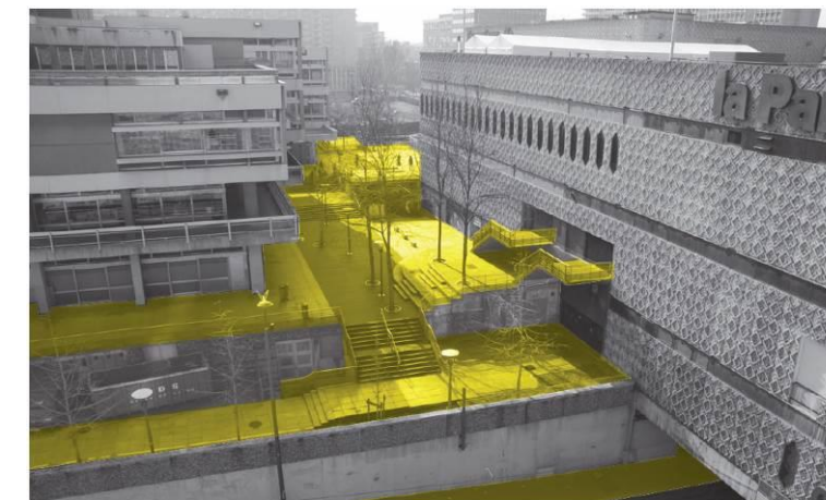
Arrière de la Bibliothèque municipale
