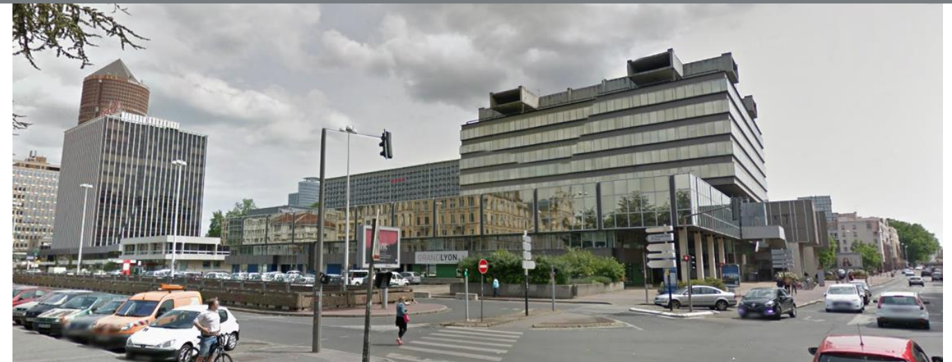
Figure 65 : Vue sur le site depuis le carrefour Garibaldi/Paul Bert (source : Googlemaps, mai 2014)
