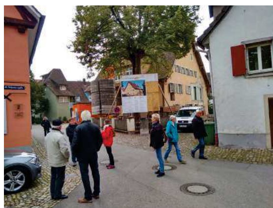
15. L'hôpital en cours de rénovation-transformation profonde
