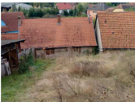
8. Maisons en contrebas du lotissement et subissant des déplacements horizontaux (la photographie suggère la forte pente locale)
