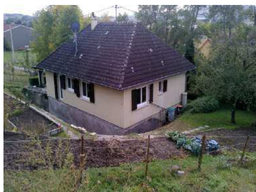
13. Une habitation récente « protégée » des déplacements horizontaux par un fossé (la photographie suggère la forte pente locale)
