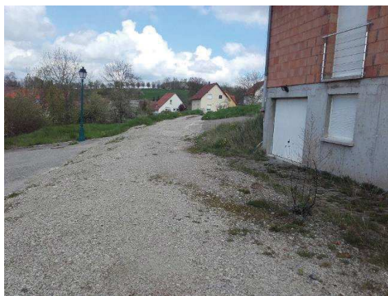
Figure 2. La maison d'habitation proche du forage géothermique défectueux
