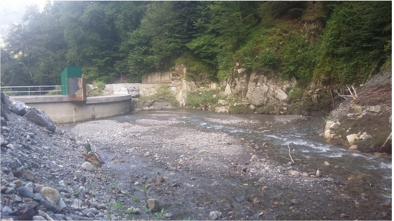
Illustration 3: Zone de curage vue depuis l'amont, rive gauche (26/07/2016)
