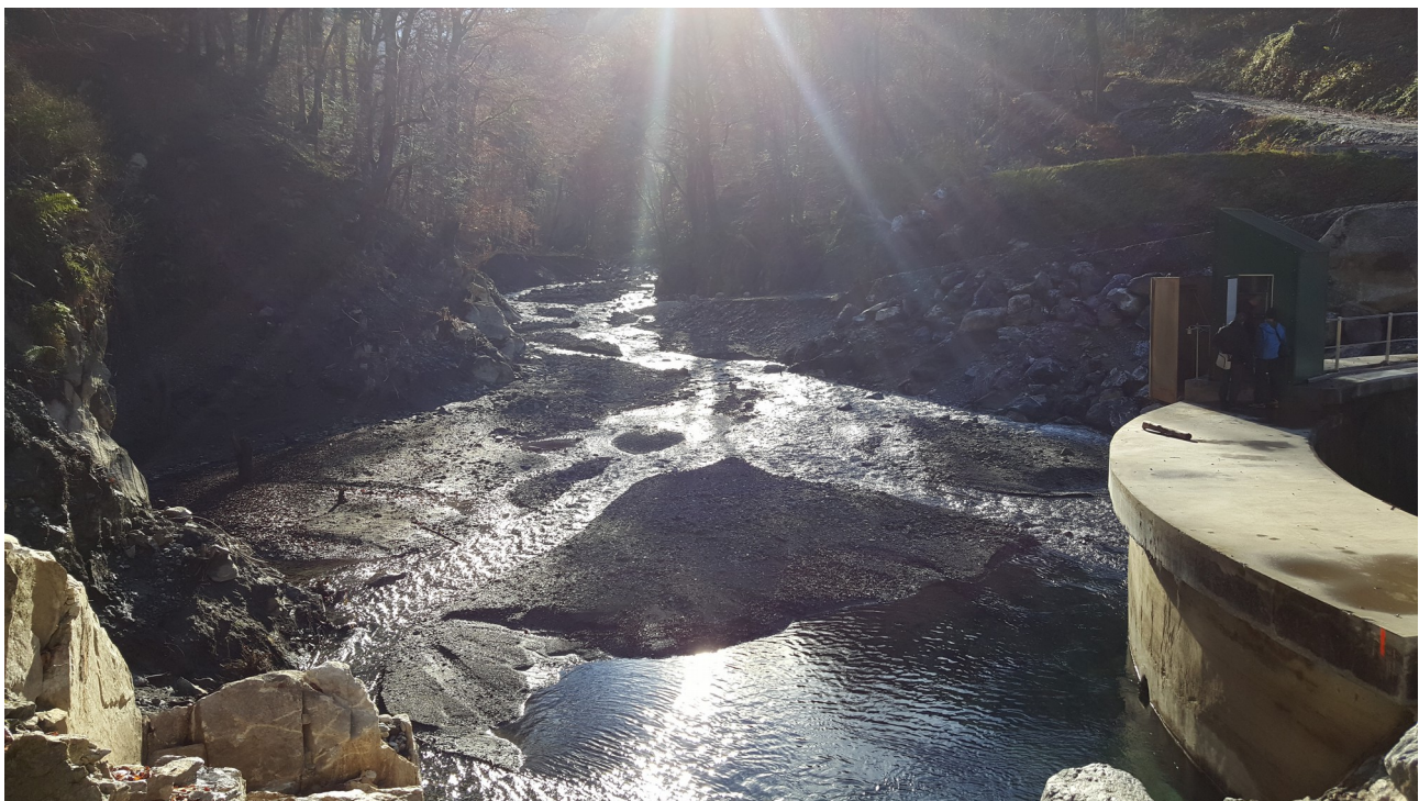
Illustration 2: Zone de curage vue depuis la rive droite (08/01/2016)
