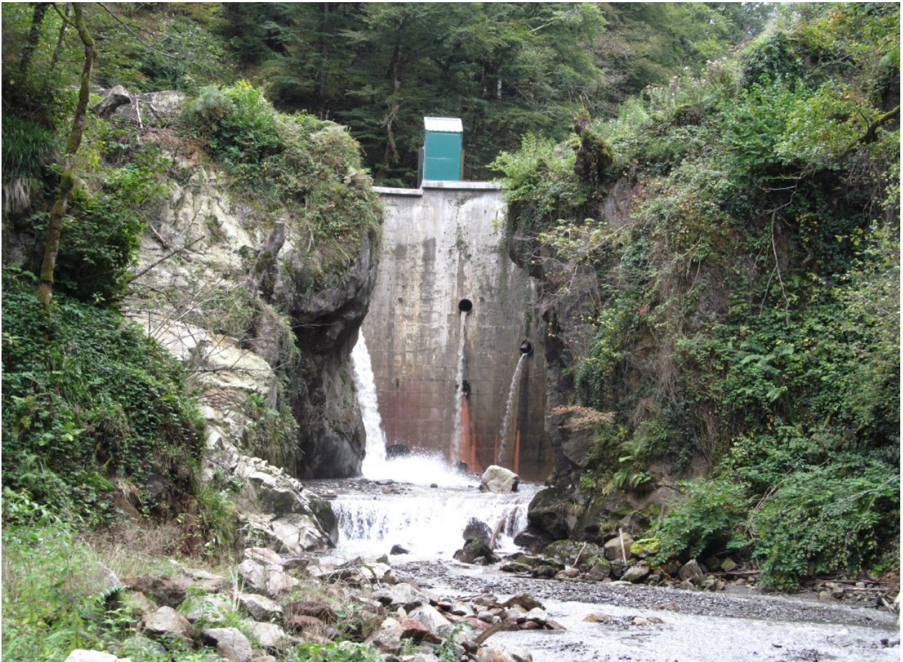
Illustration 1: Barrage de Castelveil vu depuis l'aval (11/09/2015)
