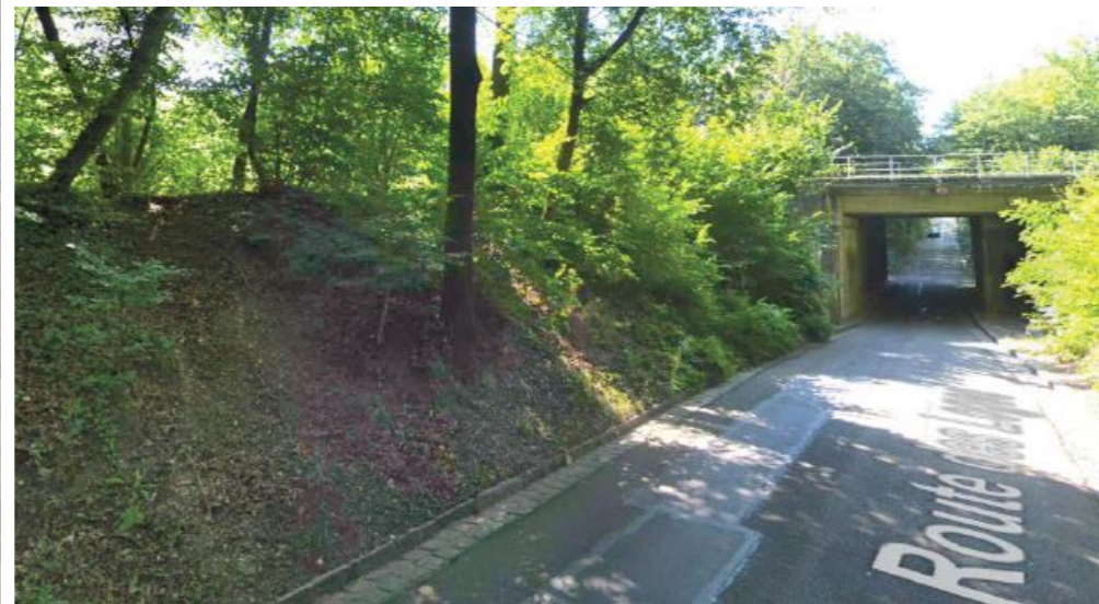
Photo 5 : Emplacement de la Sous-station du Chêne Feuillu (2021)
