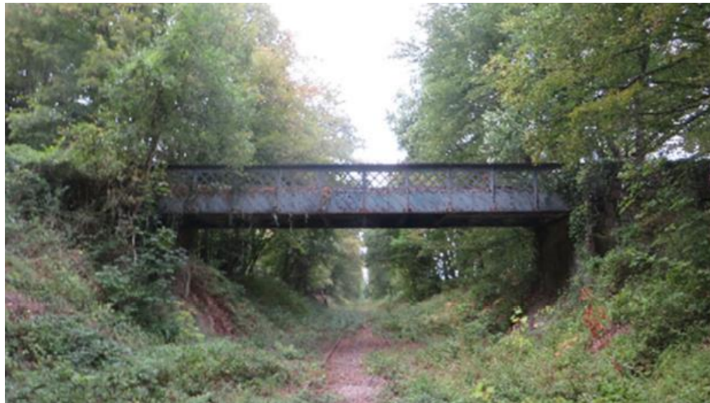
Photo 10 : Pont Route de la Mare aux Bœufs (2020)
