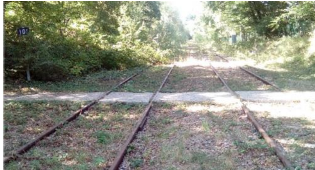
Photo 9 : Passage à niveau 10.4 et ses abords (2020)
