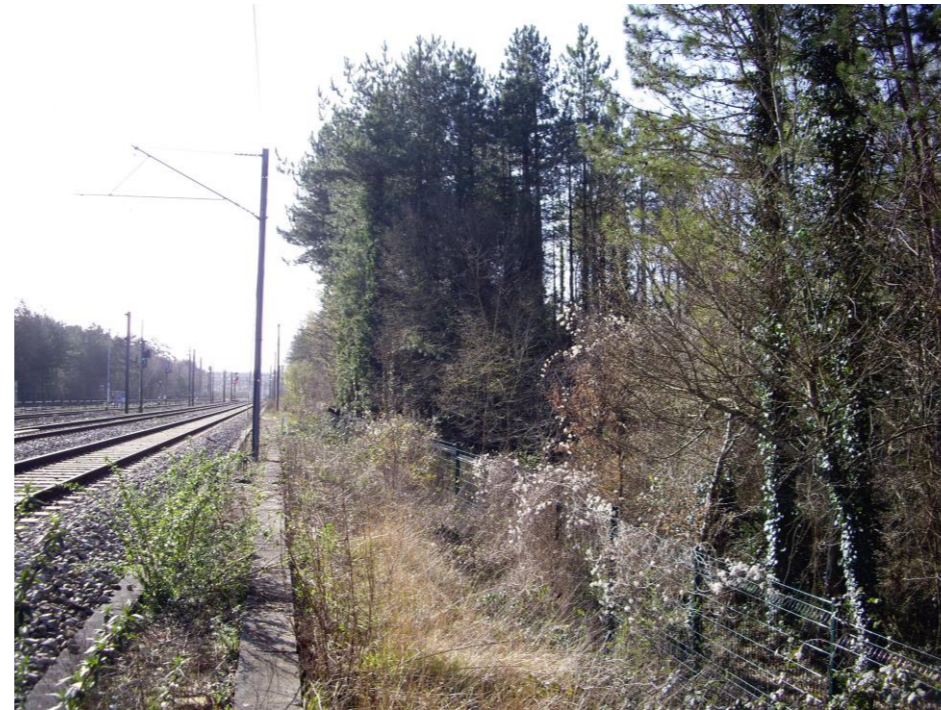
Photo 2 Vue sur la future plateforme depuis les voies exploitées (2020)
