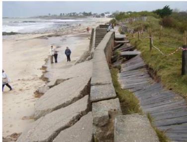
Gauche et Droite (même niveau) : Création de fissures dans le mur = fuite des sédiments = création d'une poche de vide sous les traverses de chemin de fer = Effondrement de la promenade = Affaiblissement de la structure du mur pouvant aller jusqu'à sa rupture.
