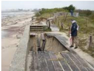
Gauche et Droite (même niveau): Démaigrissement du haut de plage. = Fuite des particules de sable sous la fondation du mur = Création d'une poche de vide sous les traverses de chemin de fer = Effondrement de la promenade.
