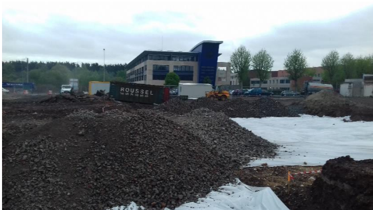
Prise de vue du remblaiement sur zone ZPC6
