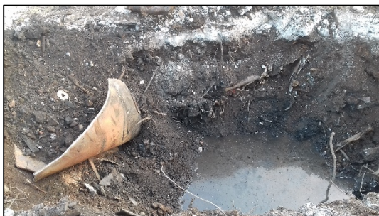
Photo 3 :vue sur la fouille du point SG
