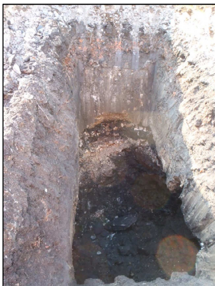
Photo 1 : vue sur la fouille du point SA
