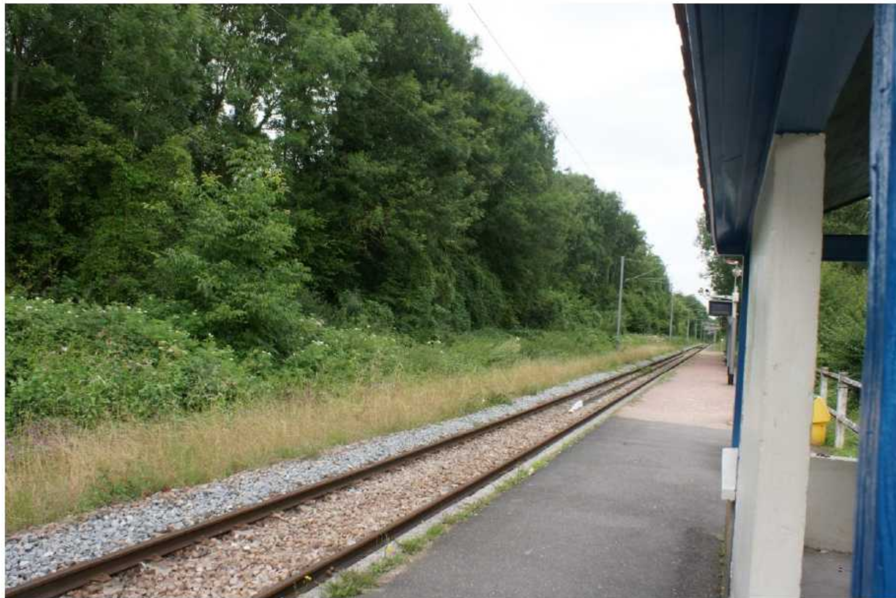
Illustration 6. Vue du quai existant en gare de Mouroux (vue vers Paris)
