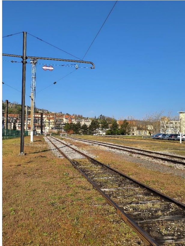
Figure 6 : Voies de chemin de fer
