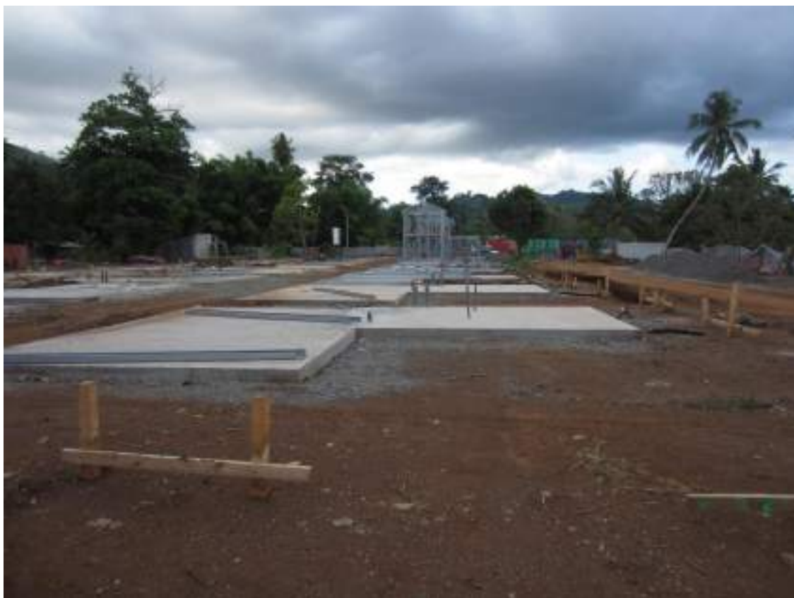
Figure 24 : Zone projet en chantier
