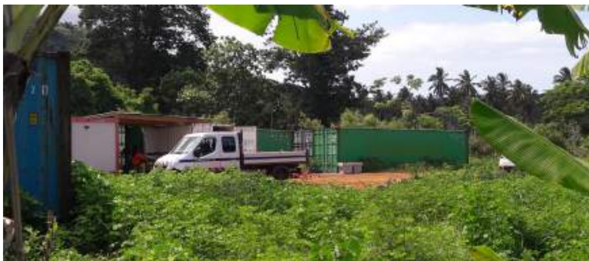
Figure 23 : Installations de chantier hors zone projet
